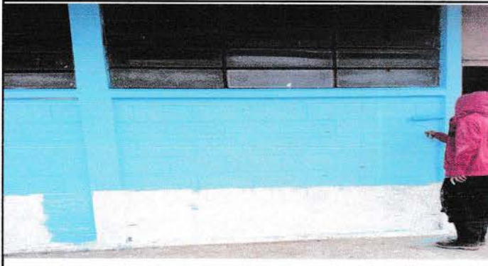
Foto 3: pintura en muros interiores y exteriores.
