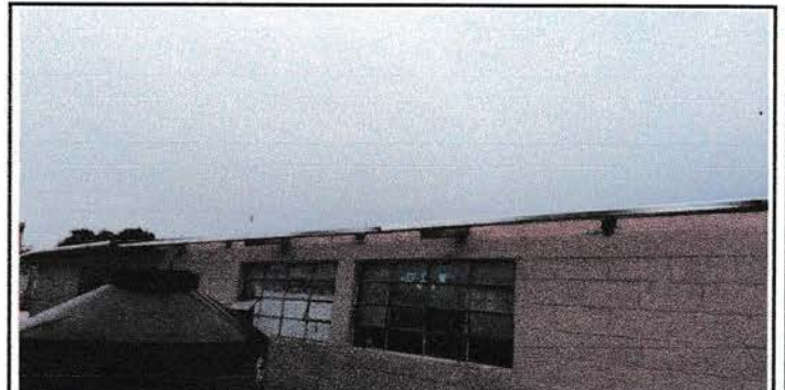
Foto 6: Sustitución de canales de pvc a metal.
