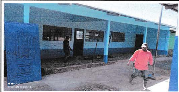
Foto 5: Sustitución de puertas de metal.
