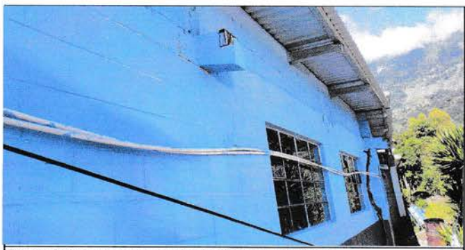
Foto 5: Mejoramiento en muros interiores y exteriores
