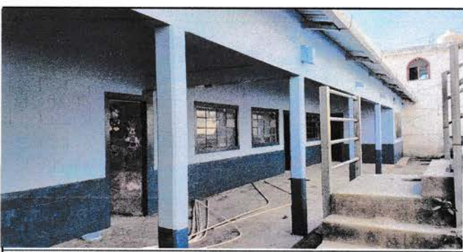
Foto 6: Pintura en muros interiores y exteriores
