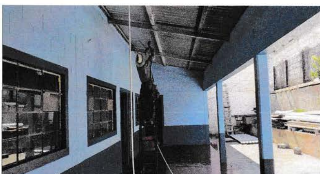
Foto 4: Sustitución de soporte de madera por metal.
