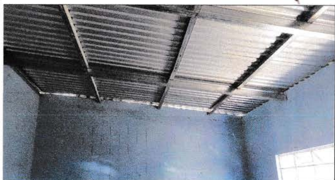
Foto 3: Sustitución de soporte de madera por metal.
