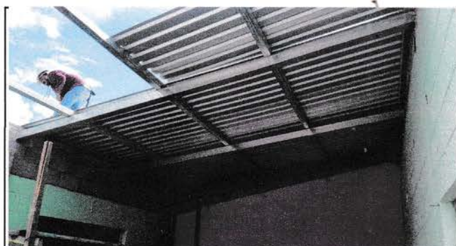
Foto 3: Sustitución de soporte de madera por metal
