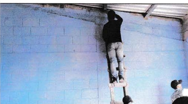
Foto 6: Pintura en muros interiores y exteriores
