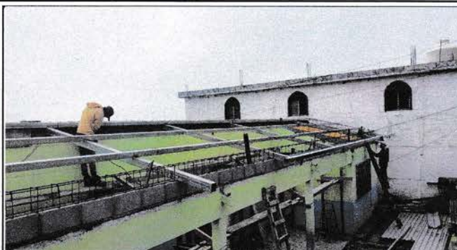
Foto 2: Sustitución de lámina
