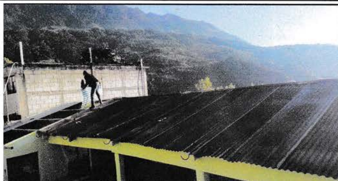
Foto 1: Sustitución de lámina
