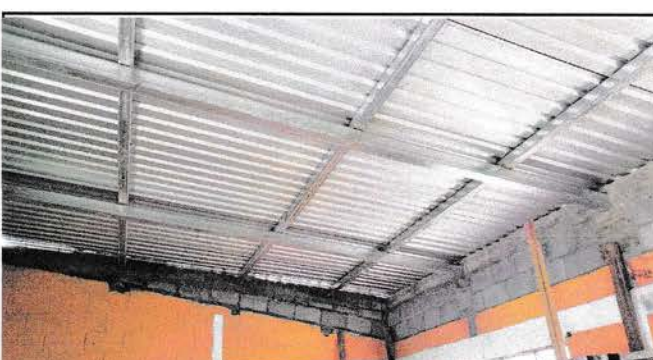
Foto 4: Sustitución de soporte de madera por metal
