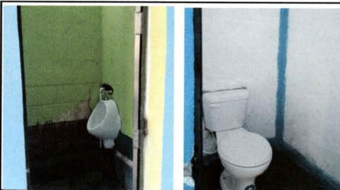
Foto 9: Red de agua potable en baños
