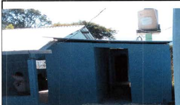
Foto 2: Estructura de techo
