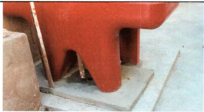
Foto 8: Reparación de drenaje
