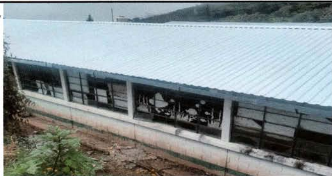
Foto1: Techo de lámina
