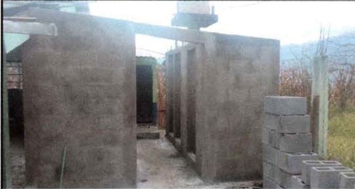
Foto 7: Servicios sanitarios y sus accesorios
