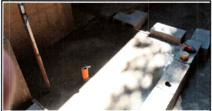
Foto 8: Reparación de drenaje
