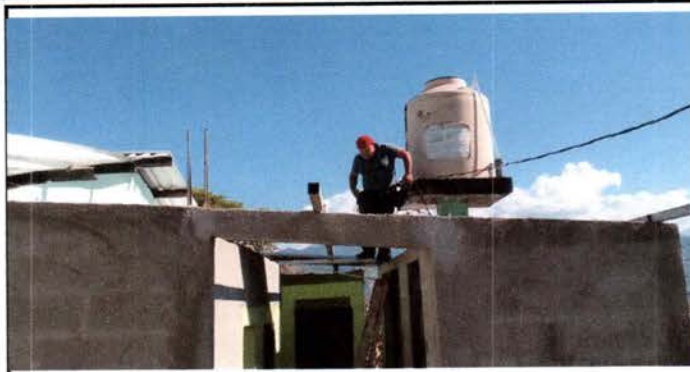
Foto 2: Estructura de techo
