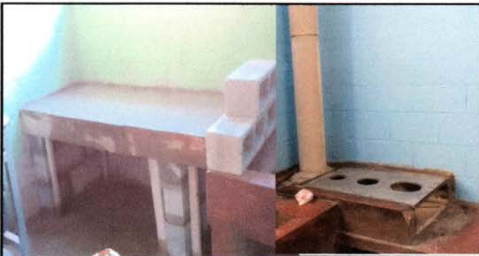
Foto 11: Reparación de cocina
