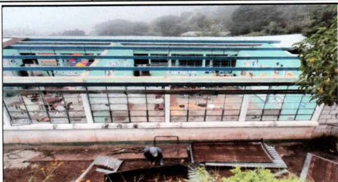
Foto1: Techo de lámina
