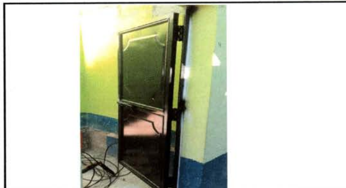
Foto 3: Puerta de metal
