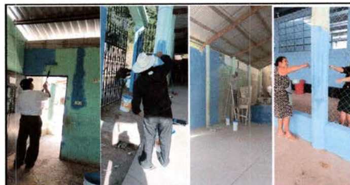
Foto 6: Pintura en muros en interiores y exteriores
