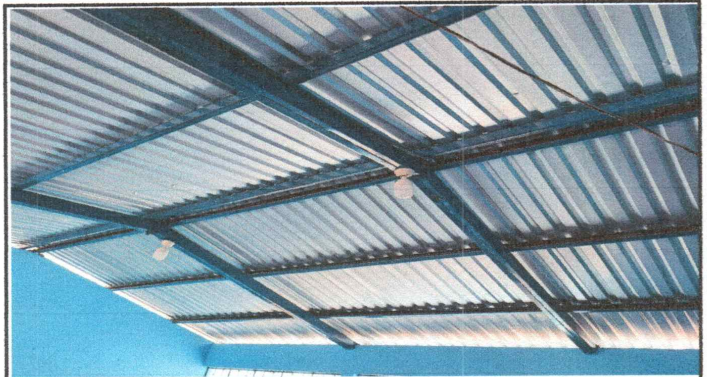
Foto 2: Sustitución de techo, lámina deteriorada.
