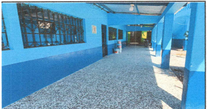
Foto 4: Sustitución de piso de granito.
