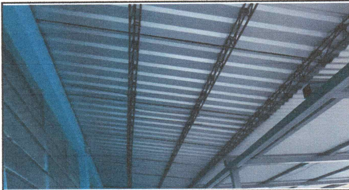
Foto1: Sustitución de lámina deteriorada
