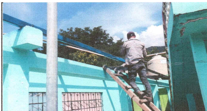
Foto 3: Sustitución de elementos de fijación de lámina
