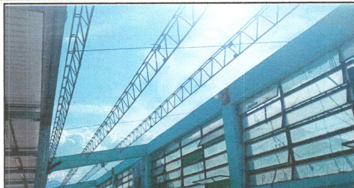
Foto 2: Sustitución de techo, lámina deteriorada
