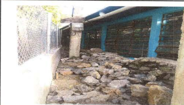
Foto 3: muro Perimental mejorado
