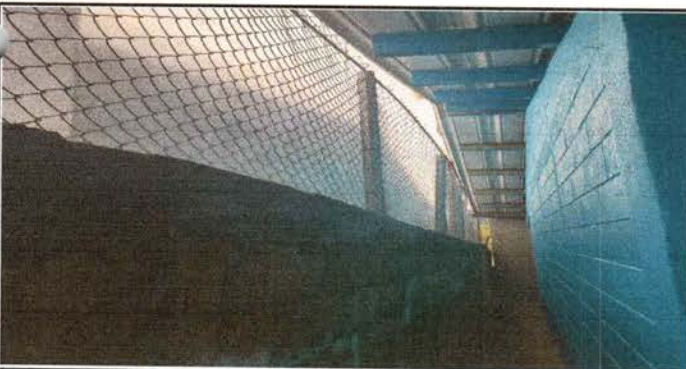
Foto 5: muro Perimental ya remosado
