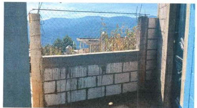
Foto 6: muro Perimental mejorado
