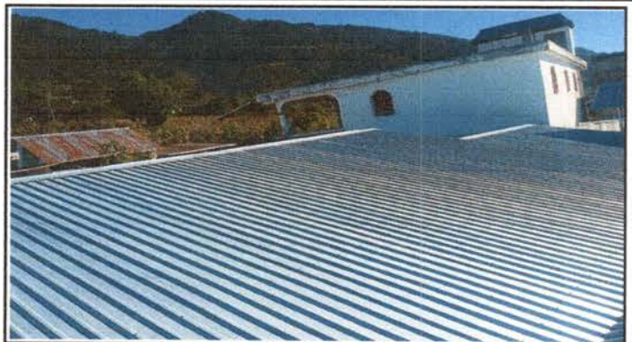
Foto 2: Cubierta de lámina completamente sustituida
