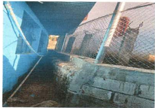
Foto 4: muro Perimental ya mejorado.
