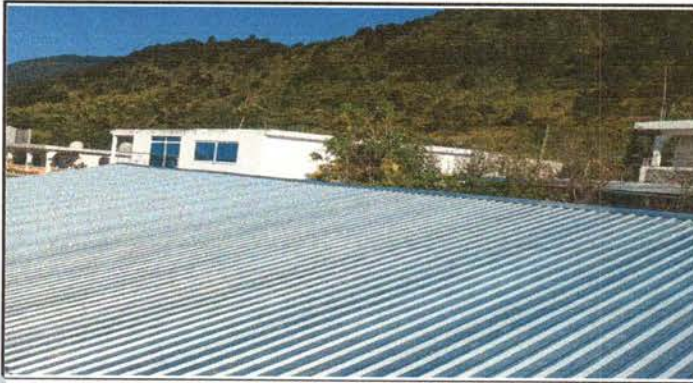
Foto 1: Cubierta de lámina sustituida
