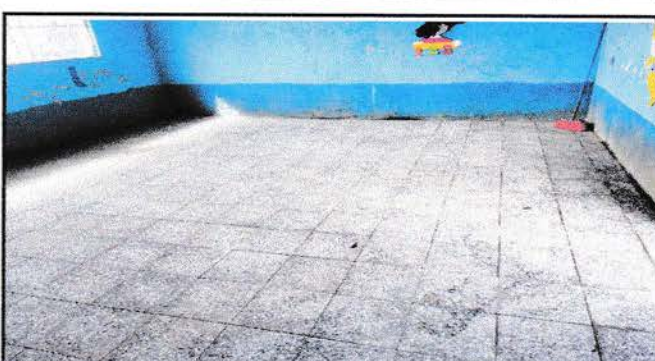
Foto 4: Sustitución de piso de torta de cemento por granito
