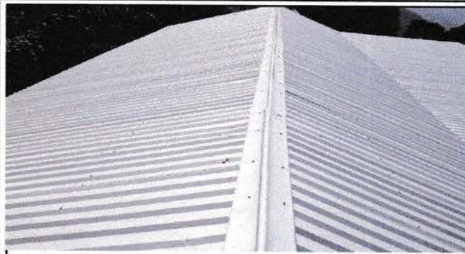
Foto 1: Sustitución de cobertura de lámina
