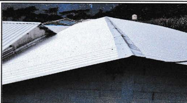
Foto 2: Sustitución de cobertura de lámina
