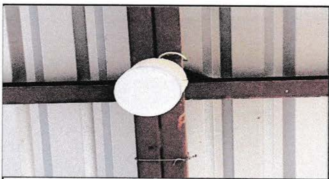
Foto 5: Sustitución de focos ahorradores
