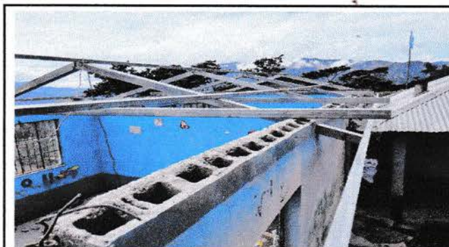
Foto 3: Sustitución de soporte de madera
