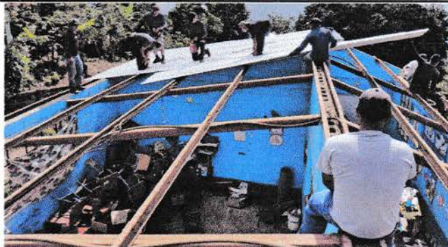
Foto 2: Sustitución de cubierta de lámina
