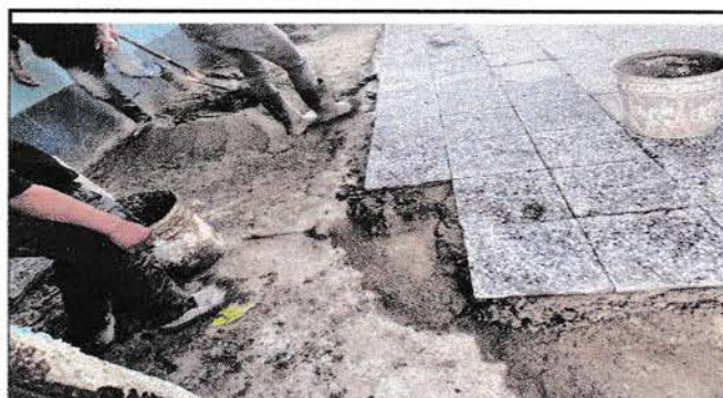
Foto 4: Sustitución de piso
