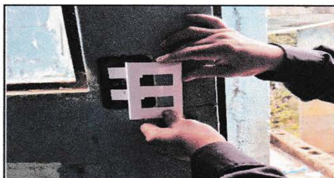
Foto 6: Sustitución de cableado eléctrico
