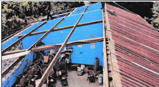
Foto 1: Sustitución de cubierta de lámina
