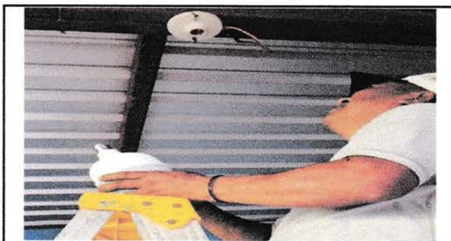
Foto 5: Sustitución de cableado eléctrico
