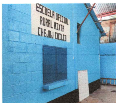
Foto 3: Sustrucion de Ventanas y Puerta
