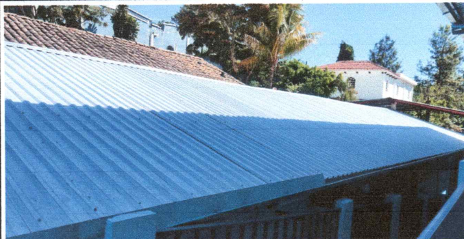
Foto 1: Sustrucion de lamina
