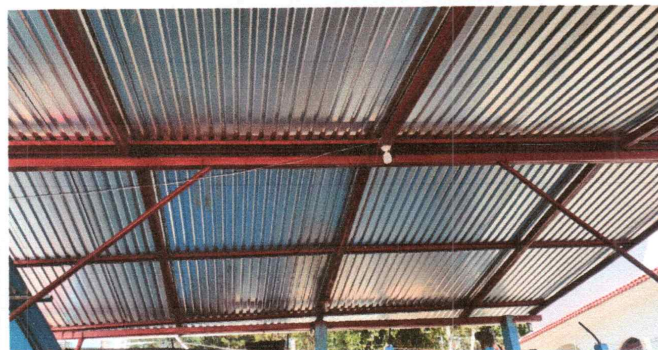
Foto 2: Sustrucion de Costaneras
