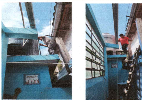
Foto 6: Sustitucion de Deposito de Agua
