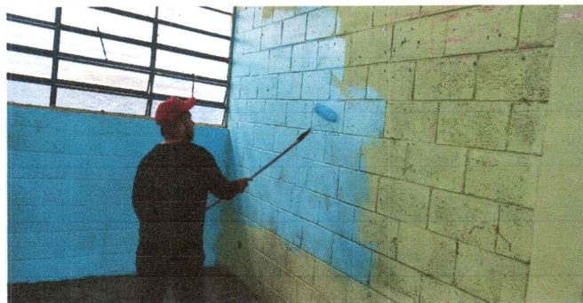
Foto 4: Pintura de Interiores y Exteriores
