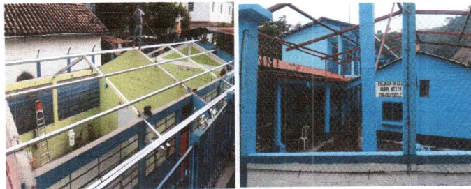
Foto 2: Sustitucion de Costaneras
