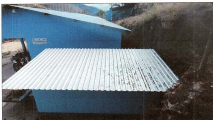
Foto 4: Lámina nueva colocada en el techo de los baños.
