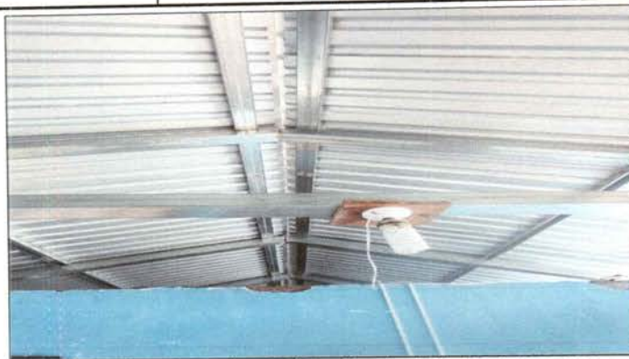
Foto 2: Estructura nueva de metal ya colocada del techo de la cocina.
