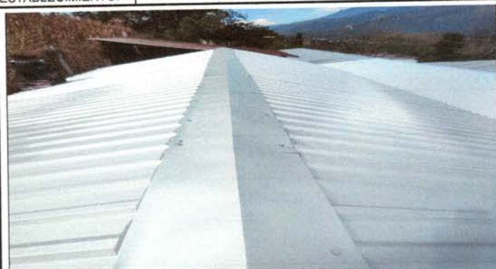
Foto1: Lamina nueva ya colocada en el techo de la cocina.
