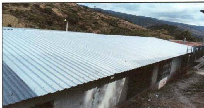
Foto 5: Lamina nueva colocada para el techo de aulas.
