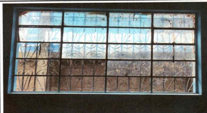
Foto 7: Ventana de aulas con vidrios nuevos.
