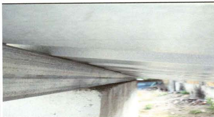
Foto 3: Estructura nueva de metal ya colocada en el techo de los baños.
