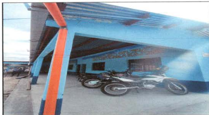
Foto 9: Canal nuevo para bajada de agua.
