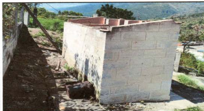
Foto 3: Estructura del techo del baño ya retirado.
