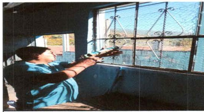
Foto 6: Colocación de vidrios a las ventanas de la cocina.
