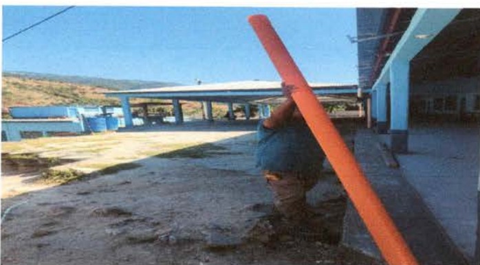
Foto 9: colocación de tubos para bajada de agua para el canal.
