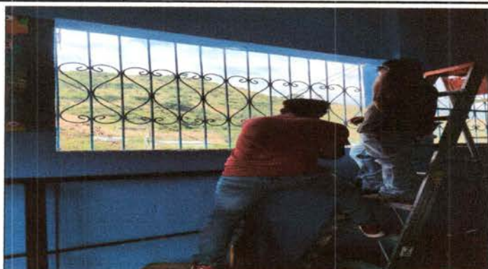
Foto 8: Colocación de ventanales de las aulas.
