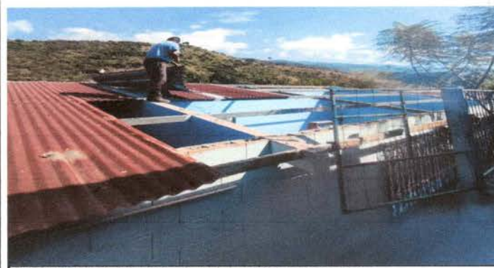
Foto 5: Retirada de lamina antigua del techo de las aulas.
