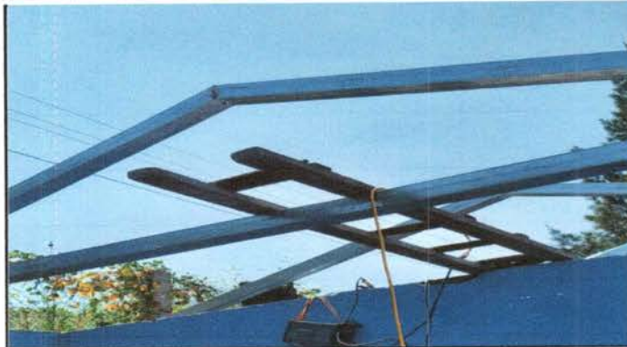
Foto 2: Colocación de la estructura de metal para el techo de la cocina
