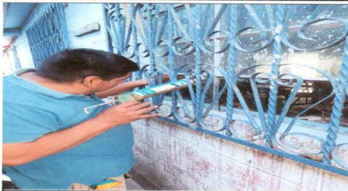
Foto 7: Colocación de las piezas nuevas de vidrios a las aulas.
