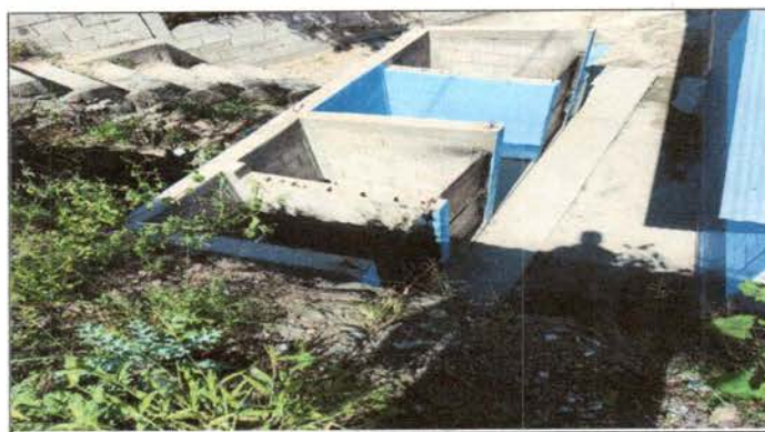
Foto 4: Lámina antigua retirada de los baños.
