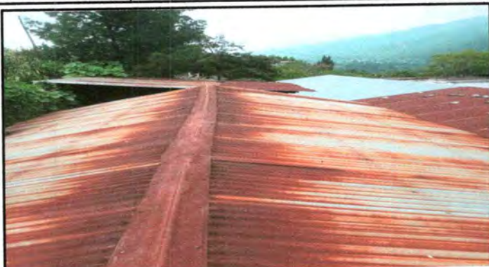
Foto 1: Láminas dañadas o en malas condiciones del techo de la cocina.
