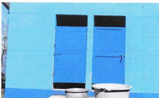
Foto 3: Sustrucción y mantenimiento de puertas
