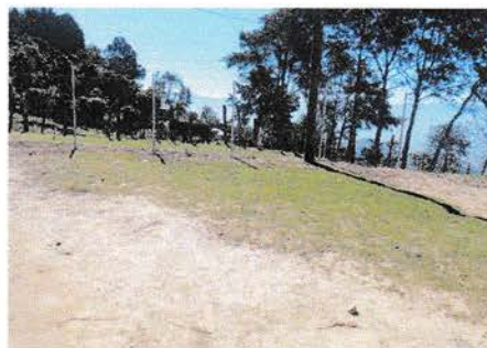
Foto 2: Reparación de tubo hg y malla galvanizada.
