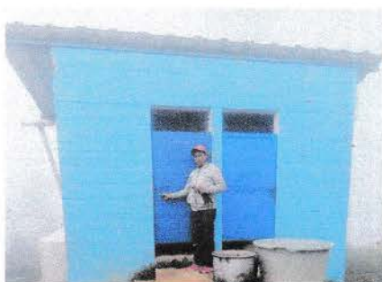
Foto 3: sustitucion y mantenimiento de puerta
