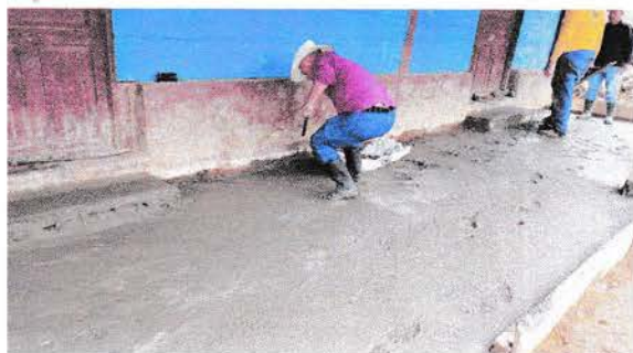
Foto 5: Sustitucion de piso de cemento liquido
