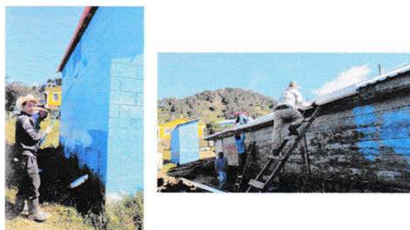
Foto 4: Pintura en muros externos e internos y reparacion de bajada de agua
