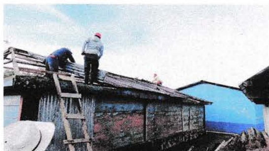
Foto1: Sustitucion de soporte de madera por metal y sustitucion de lámina
