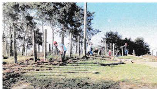
Foto 2: reparacion de tubo hg y malla galvanizada
