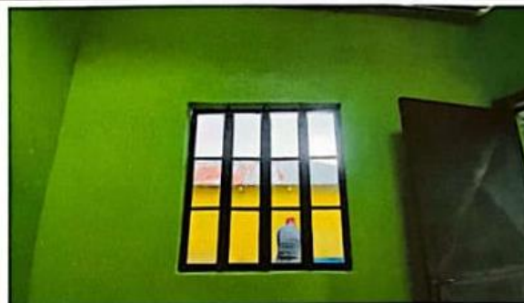
Foto 4: Sustitución de vidrios
