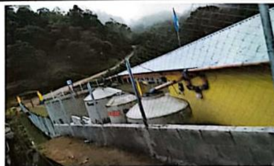
Foto 6: Reparación de muro perimetral de block en tubo hg, malla galvanizada y sustitución de deposito de agua
