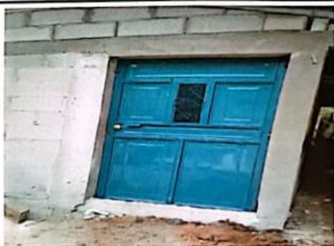
Foto 3: Sustitución de puerta de madera por metal
