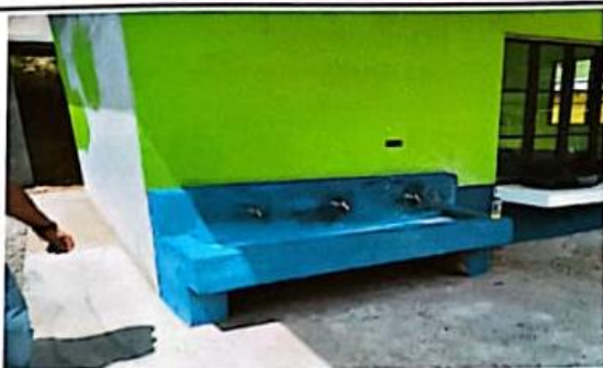
Foto 5: Sustitución de piso
