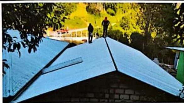
Foto1: sustitución de lámina, por lámina troquelada
