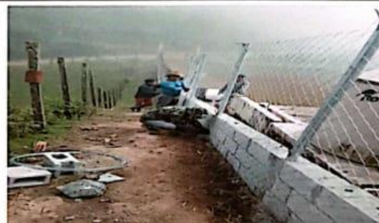
Foto 6: Reparación de muro perimetral y sustitución de deposito de agua
