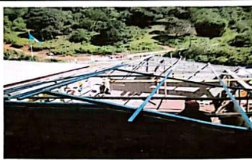
Foto 2: Sustitución de estructura de soporte de metal
