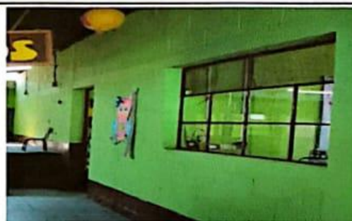
Foto 4: Sustitución de vidrios
