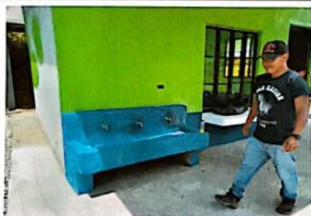
Foto 5: Sustitución de piso
