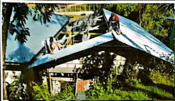
Foto1: sustitución de lamina
