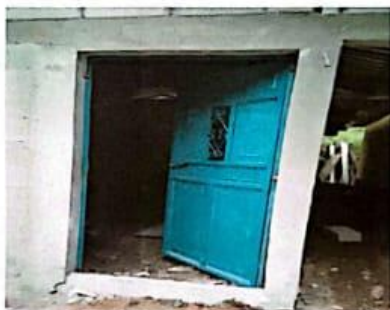
Foto 3: Sustitución de puerta de metal
