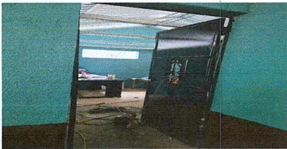
Foto 5: Sustitución de puerta
