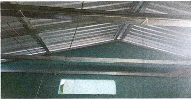
Foto 3: sustitución de estructura de soporte
