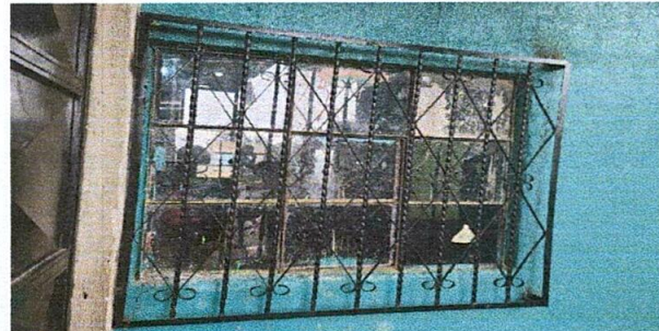
Foto 6: sustitución de balcon
