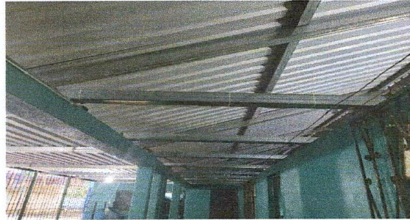
Foto 4: sustitución de estructura de soporte
