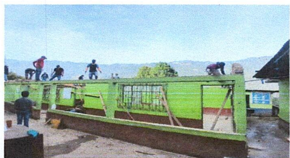
Foto 6: sustitución de balcon
