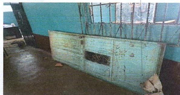
Foto 5: Sustitución de puerta
