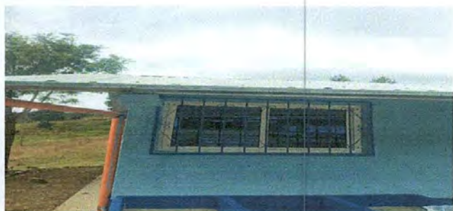
Foto 3: Canales y bajadas de agua instalados.
