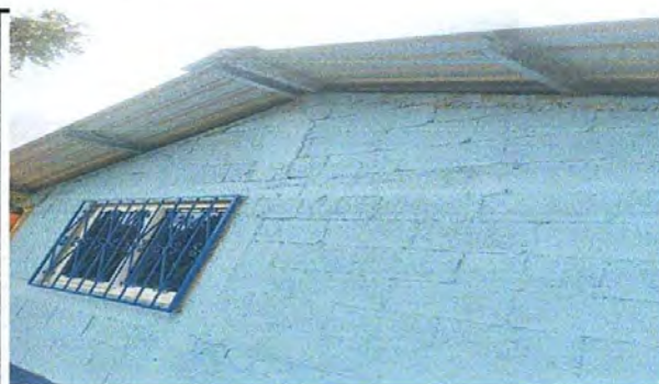
Foto 4. sustitución de lámina de cocina.
