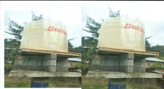
Foto 6: Depósito de agua sustituido.
