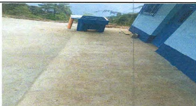
Foto 3: Piso terminado en cocina.
