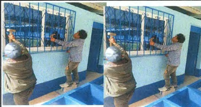
Foto 2: Sustitución de ventanas de cocina.
