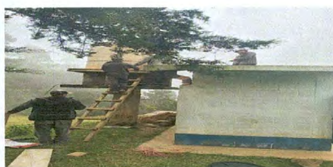
Foto 6: Sustituyendo depósito de agua.
