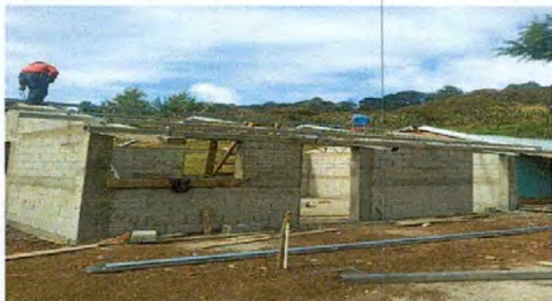
Foto 1: Reparación de techo de cocina.
