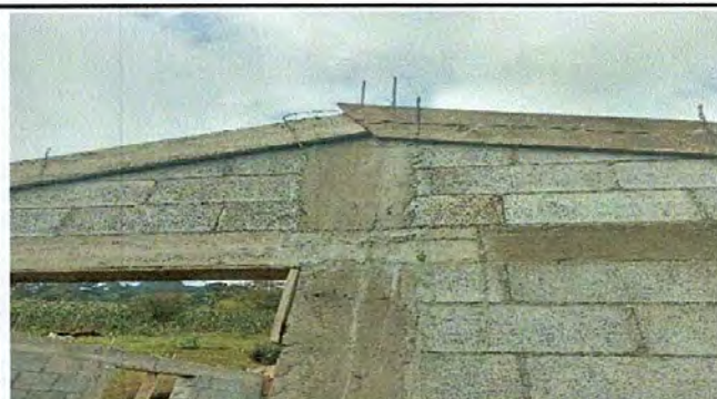
Foto 4: Mejorando pared de cocina.
