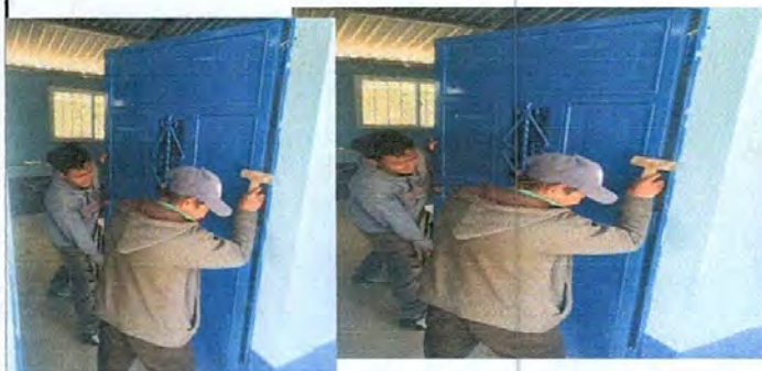
Foto 5: Sustituyendo puerta de cocina.
