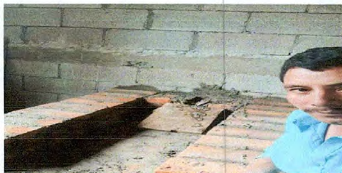
Foto 1: Instalación de estufa rural.
