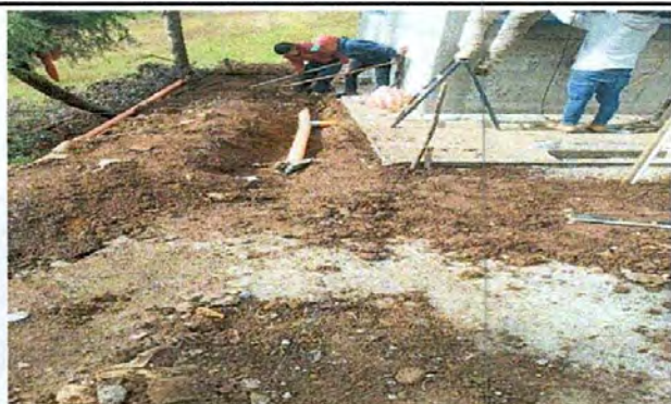
Foto 3: Instalación de bajadas de agua.
