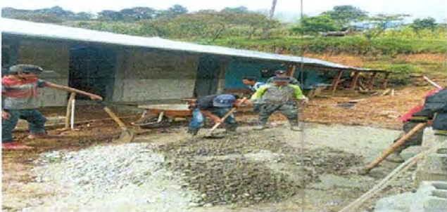
Foto 3: Tendiendo piso en cocina.
