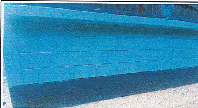
Foto 3: Pintura en muros interiores y exteriores
