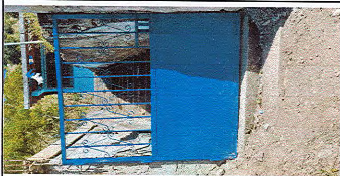
Foto1: Sustrucción de portón de metal
