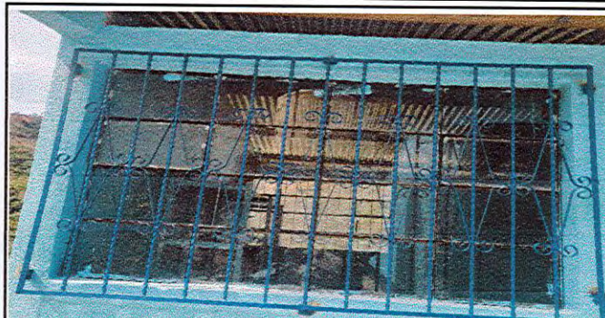
Foto 2: Sustrucción de vidrios
