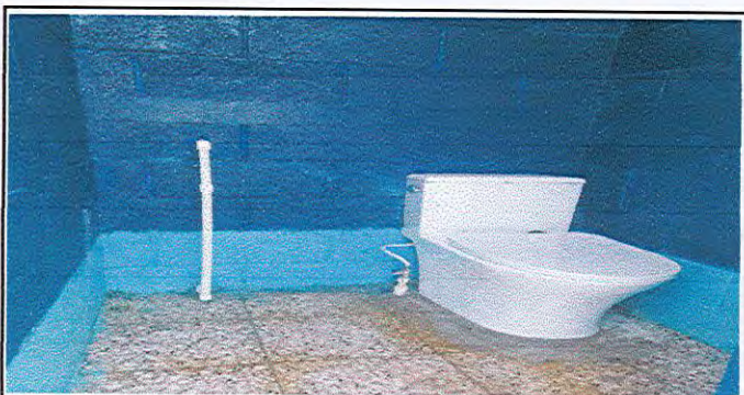
Foto 5: Sustrucción de tubería
