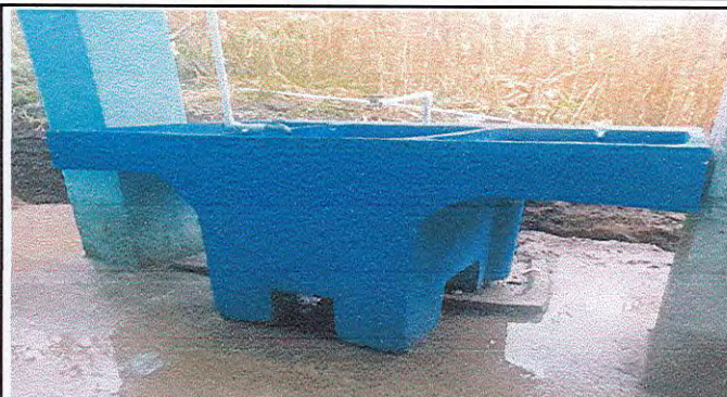
Foto 8: Sustitución de pila de cemento
