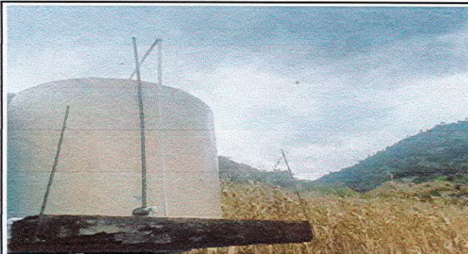
Foto 7: Sustitución de depósito de agua.
