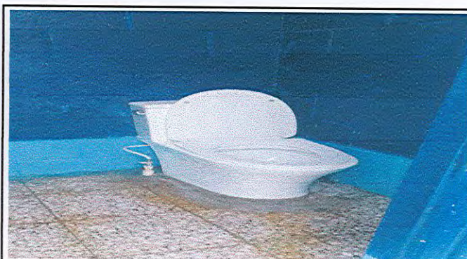
Foto 4: Sustrucción de inodoros
