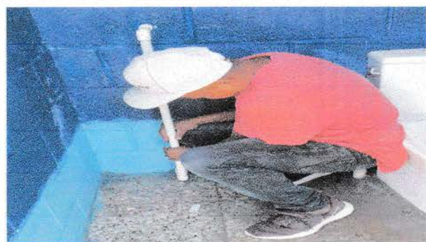
Foto 5: Sustitución de tubería
