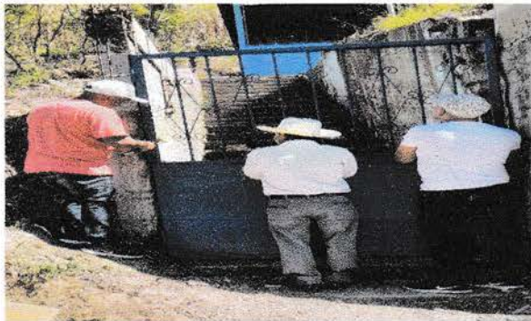
Foto1: Sustitución de portón de metal
