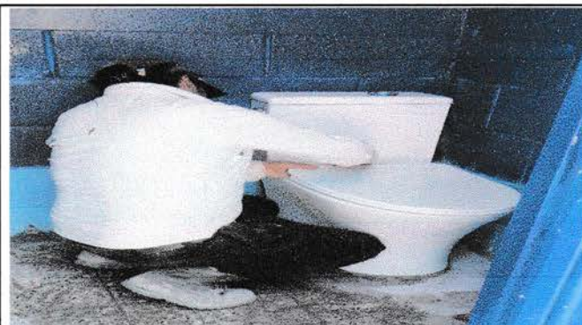
Foto 4: Sustitución de inodoros
