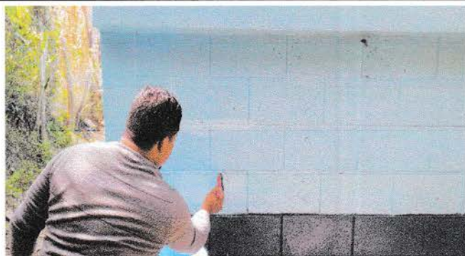
Foto 3: Pintura en muros interiores y exteriores
