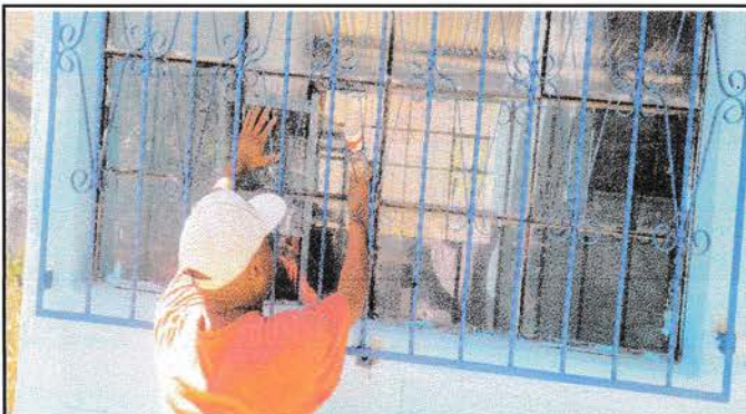
Foto 2: Sustitución de vidrios
