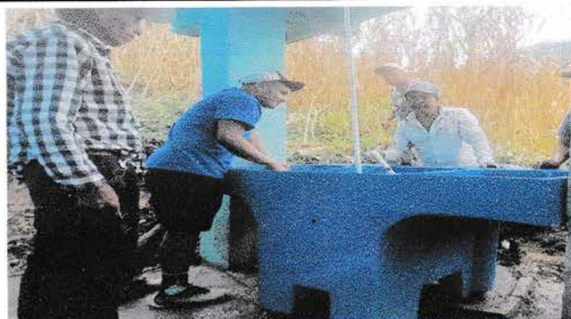
Foto 8: Sustitución de pila de cemento
