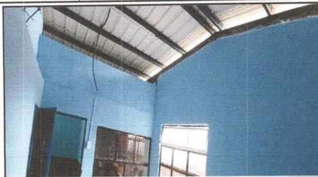
Foto 2: Mejoramiento de la cocina.
