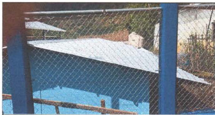
Foto 5: sustitución de lámina
