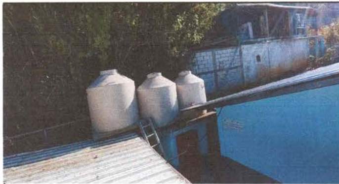
Foto 3: sustitución de tinaco
