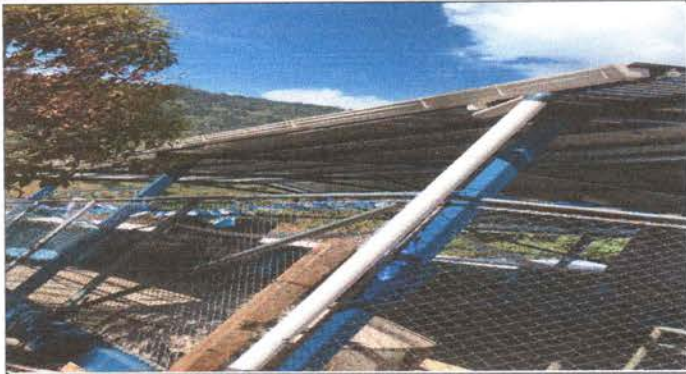
Foto1: sustitución de canales
