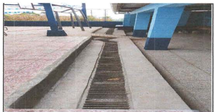
Foto 6: mejoramiento de cuneta.
