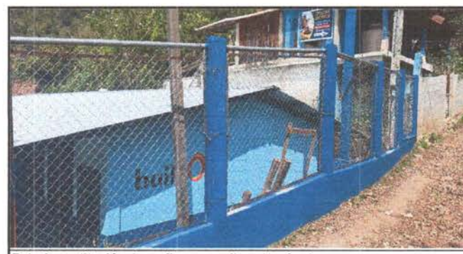
Foto 6: sustitución de malla, por malla galvanizada
