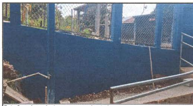
Foto 5: mejoramiento en muro perimetral
