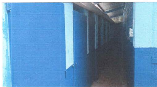
Foto 4: mejoramiento de sanitarios, techos, piso, lavamanos paredes y puertas.
