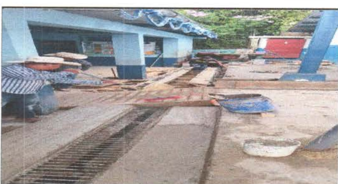
Foto 6: mejoramiento de cuneta.
