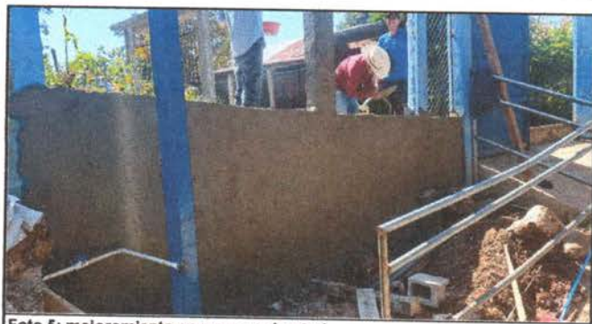
Foto 5: mejoramiento en muro perimetral
