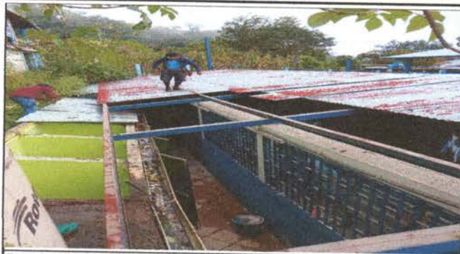
Foto 1: cambio de lamina, y sustitucion de costanera de madera por metal
