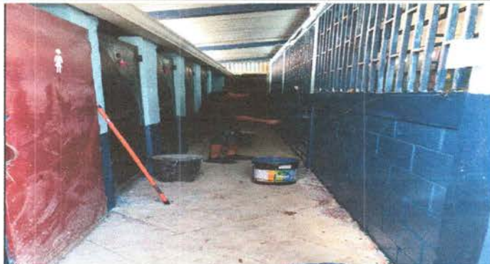
Foto 2: pintura interior y exterior.
