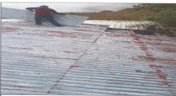
Foto 5: sustitución de lámina
