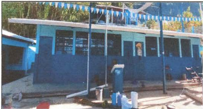
Foto1: sustitución de canales
