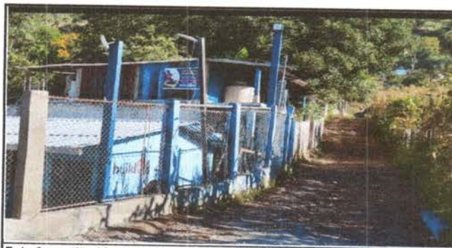
Foto 6: sustitución de malla, por malla galvanizada
