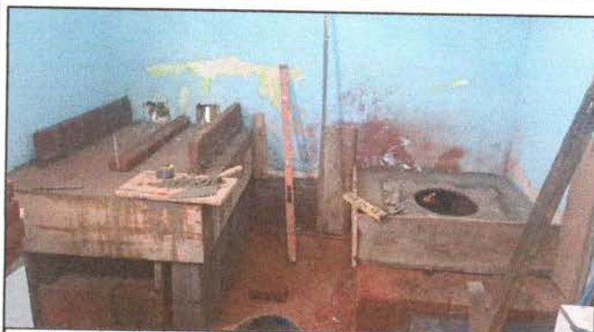
Foto 3: sustitución de planchas, mejoramiento en mesas de trabajo y lavatrazos.
