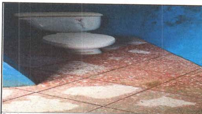
Foto 4: mejoramiento de sanitarios, techos, piso, lavamanos paredes y puertas.
