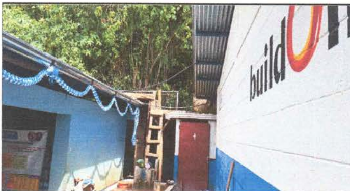
Foto 3: sustitución de tinaco
