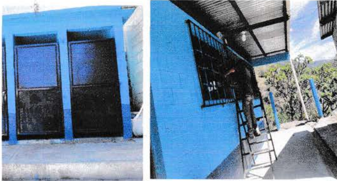
Foto 1: Puertas Y ventanas Listas.
