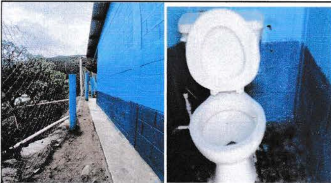
Foto 3: Sustitucion de Pintura y sanitarios.
