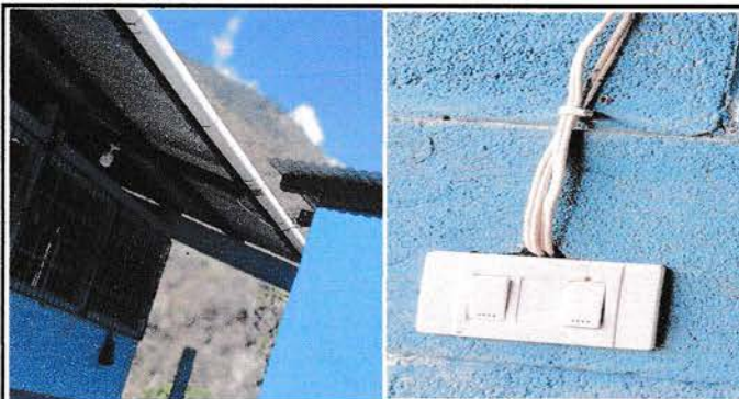
Foto 5: Sustitucion de focos e interruptores.
