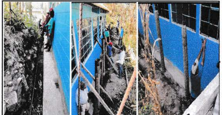
Foto 4: Sustitucion de columnas y circulación.
