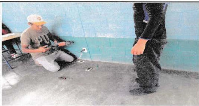
Foto 5: Sustitucion del sistema eléctrico.
