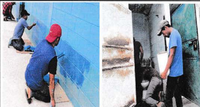
Foto 3: Sustitucion de inodoros y pintura.
