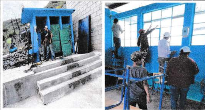
Foto 1: Sustitucion de puertas de metal y ventanas.
