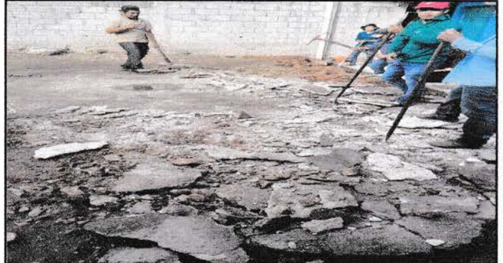
Foto 2: Sustitucion de pisos de torta de concreto
