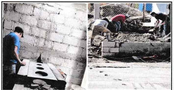
Foto 6: Sustitucion de plancha y pila de concreto.
