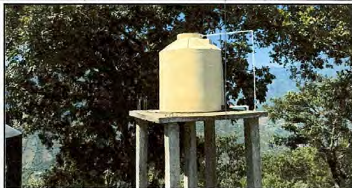
Foto7: Déposito de 1700 lt. susustituido.
