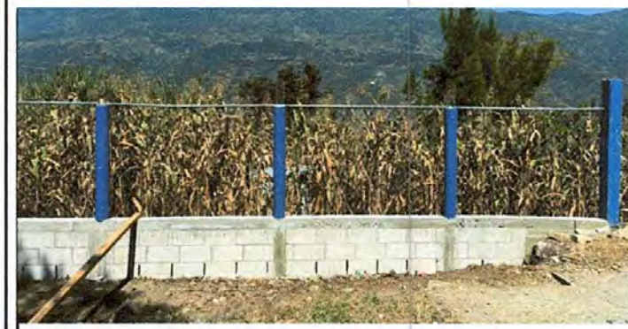
Foto 5: Continuación de muro perimetral finalizado
