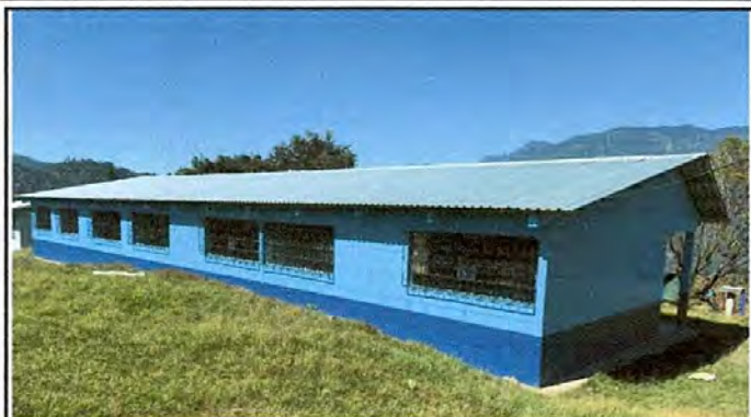
Foto 2: Sustrucción de pintura en interiores y exteriores finalizado.
