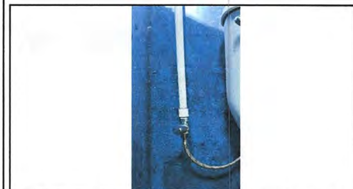
Foto 3: Sustrucción de accesorios inodoro (contra llave, tubo de abasto y tanque) finalizado.
