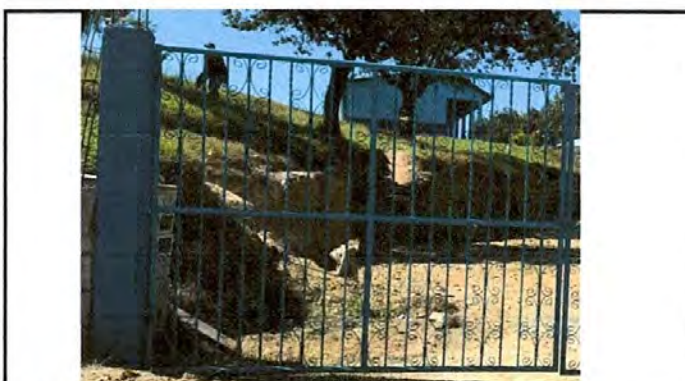
Foto 4: Mantenimiento a portones de metal finalizado.
