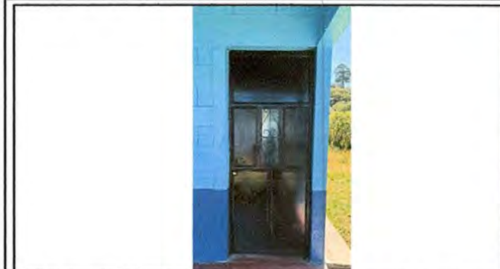
Foto 1: Sustrucción de chapas y mantenimiento de puertas finalizado.
