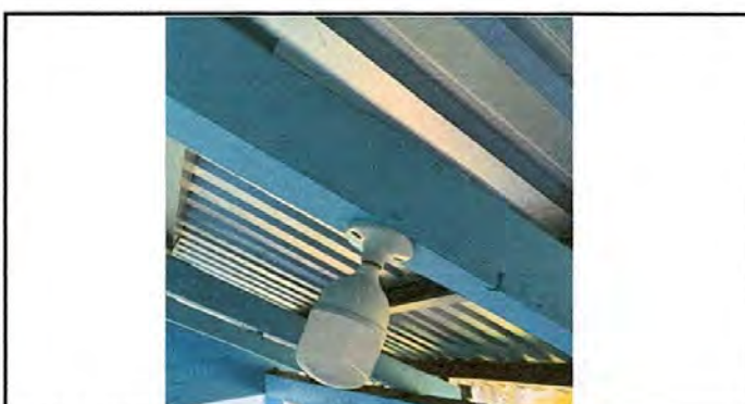
Foto 6: Plafoneras, focos y cableado sustituido.
