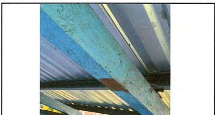
Foto 6: Sustrucción de plafoneras, focos y cableado en proceso.
