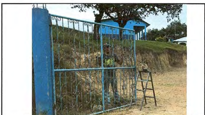
Foto 4: Mantenimiento a portones de metal en proceso.
