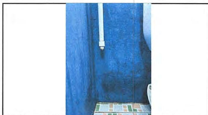
Foto 3: Sustrucción de accesorios inodoro (contra llave, tubo de abasto y tanque) en proceso.
