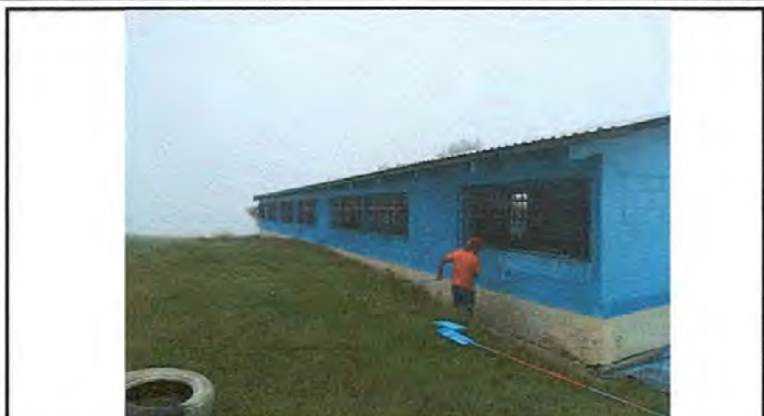
Foto 2: Sustrucción de pintura en interiores y exteriores en proceso.
