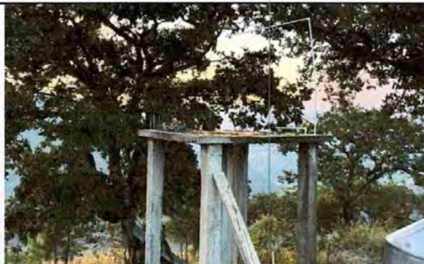
Foto7: Sustitución de depósito de 1700 lt. en proceso.
