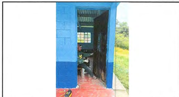
Foto1: Sustrucción de chapas y mantenimiento de puertas en proceso.
