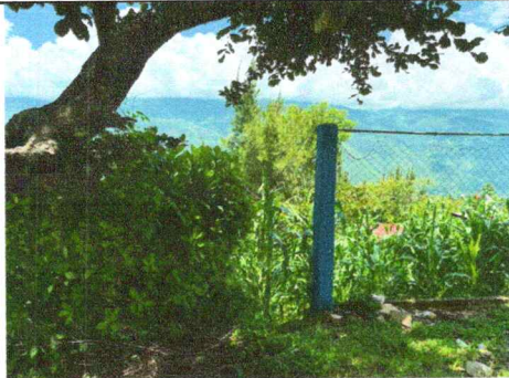
Foto 5: Continuación de muro perimetral.
