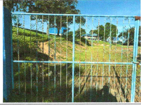
Foto 4: Mantenimiento a portones de metal.
