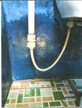
Foto 3: Sustrucción de accesorios inodoro (contra llave, tubo de abasto y tanque) en mal estado.
