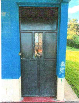
Foto 1: Sustrucción de chapas y mantenimiento de puertas en mal estado.
