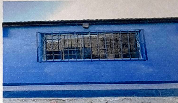
Foto 2: Sustitución de vidrios y mejoramiento de ventanas con balcones
