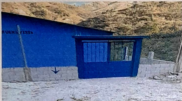
Foto1: Sustitución de portón de metal
