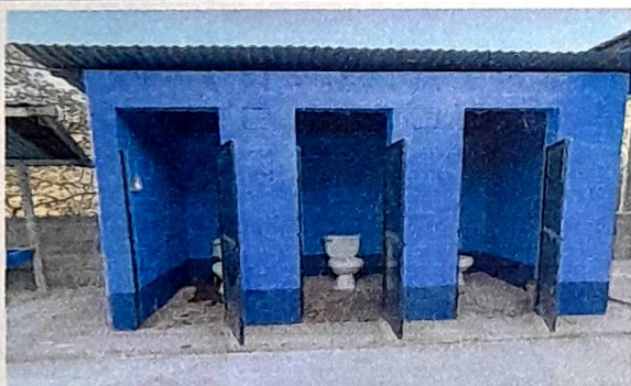
Foto 3: Sustitución de inodoro y llave de paso
