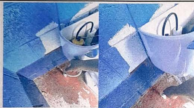
Foto 3: Instalando sanitarios y red de agua
