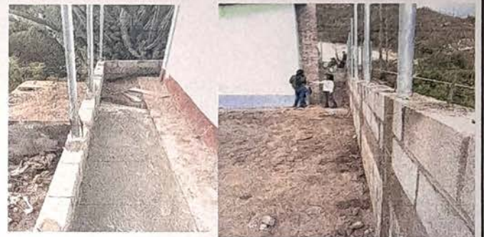
Foto 4: Circulación de muro en proceso
