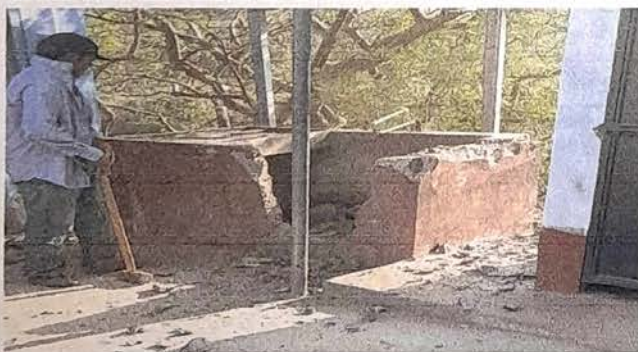
Foto 5: Pila para su mejoramiento
