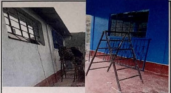
Foto 2: Instalando balcones a ventanas
