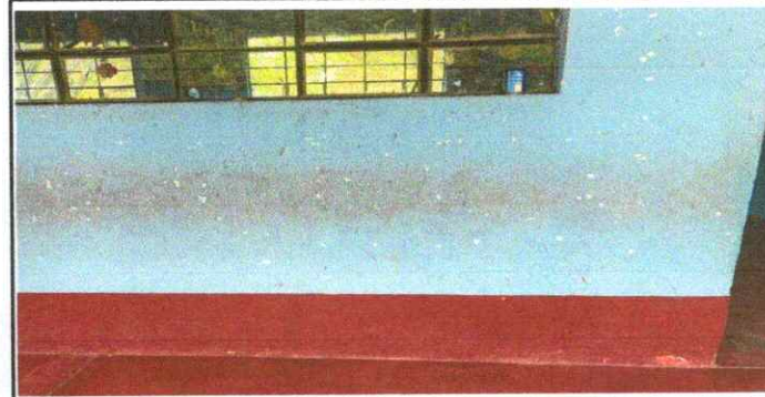
Foto 6: Pintura deteriorada
