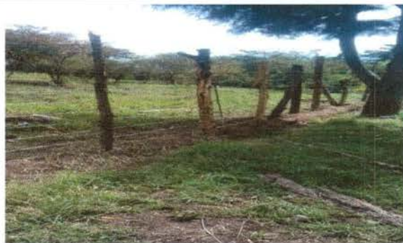
Foto 11: Reparación de cerco de pua
