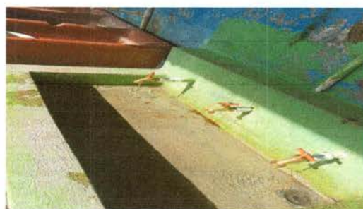
Foto 16: Sustitución de llaves de chorro
