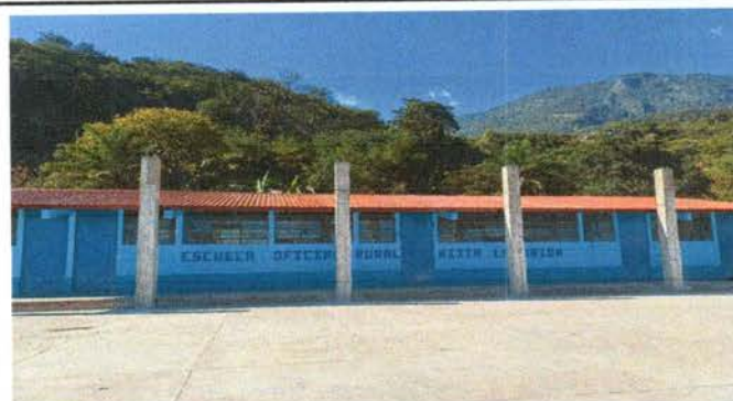
Foto 2: Sustitución de lámina en aulas
