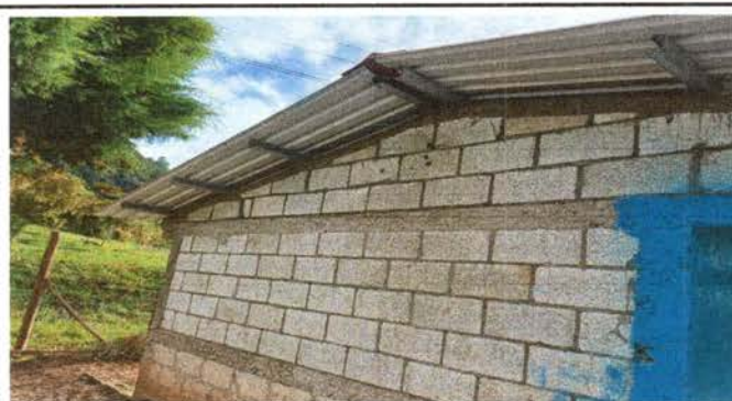
Foto 4: Sustitucion de estructura de soporte de madera por metal en techo de cocina escolar
