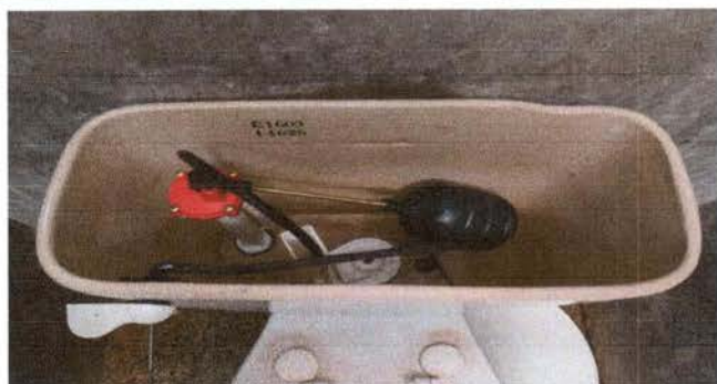
Foto 9: Sustitución de accesorios de inodoro
