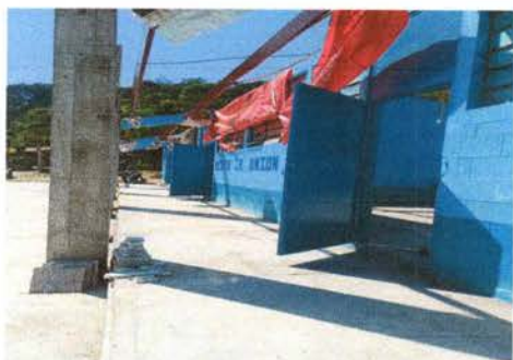
Foto 17: Aplicación de pintura a puertas
