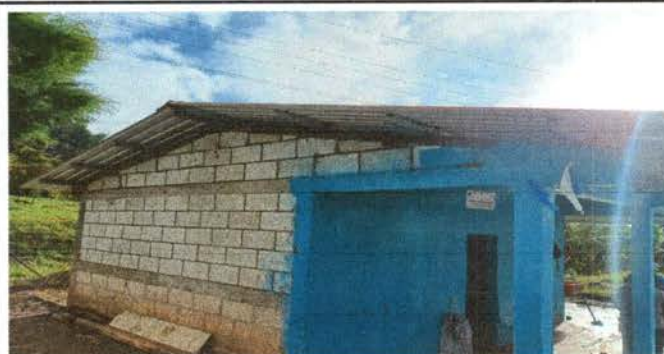
Foto 3: Sustitución de lámina en cocina escolar
