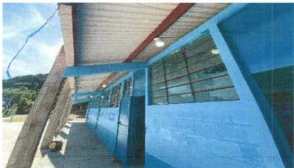
Foto13: Sustitucion de focos ahorradores
