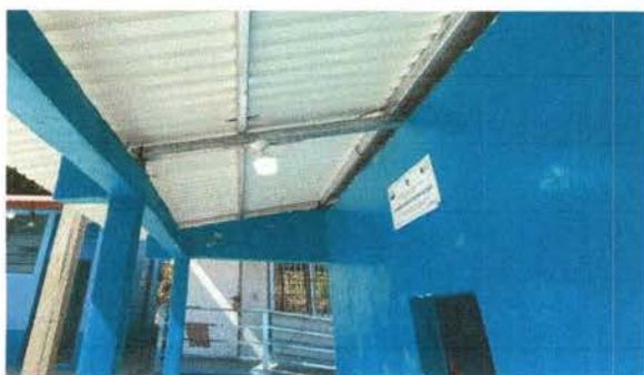
Foto 15: Reparación de cableado eléctrico
