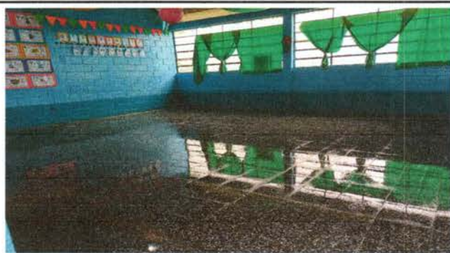
Foto 5: Sustitución de piso por piso de granito en aula
