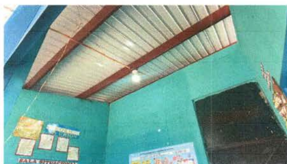
Foto 14: Sustitucion de plafoneras
