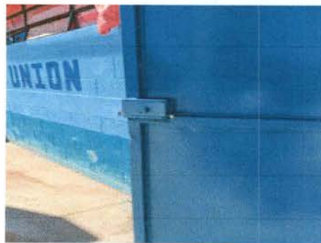
Foto 18: Sustitución de chapas
