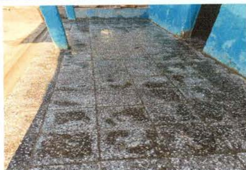
Foto 8: Sustitucion de piso por piso de granito en cocina escolar (exterior) corredor
