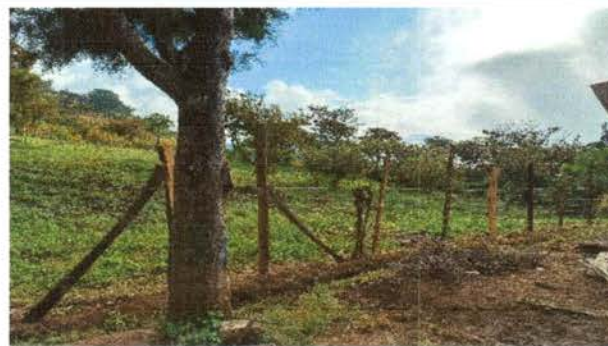
Foto 12: Reparación de cerco de pua
