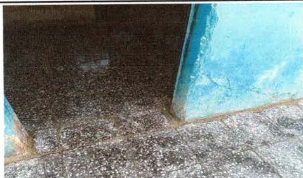
Foto7: Sustitucion de piso por piso de granito en cocina escolar (interior)
