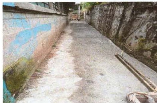
Foto 10: Reparación de cuneta de concreto
