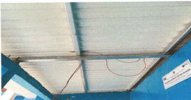
Foto 15: Reparación de cableado eléctrico
