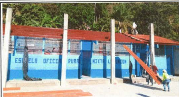
Foto 1: Sustitución de lámina en aulas
