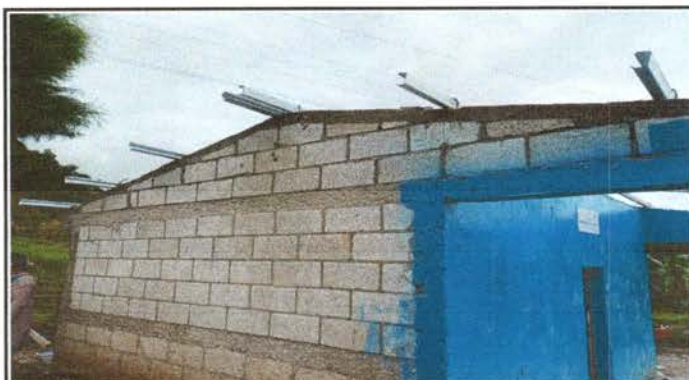
Foto 3: Sustitución de lámina en cocina escolar
