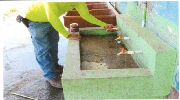
Foto 16: Sustitución de llaves de chorro
