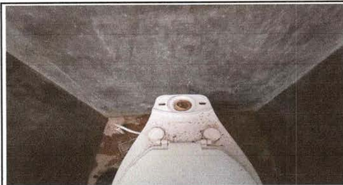
Foto 9: Sustitución de accesorios de inodoro
