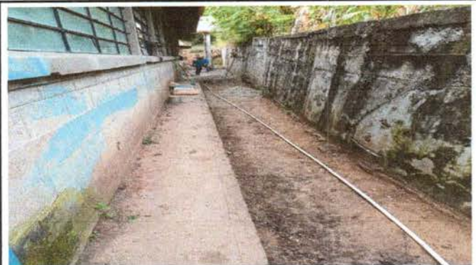
Foto 10: Reparación de cuneta de concreto
