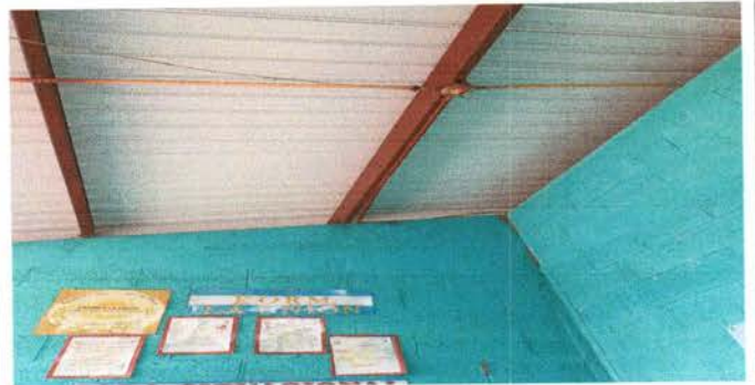
Foto 14: Sustitución de plafoneras
