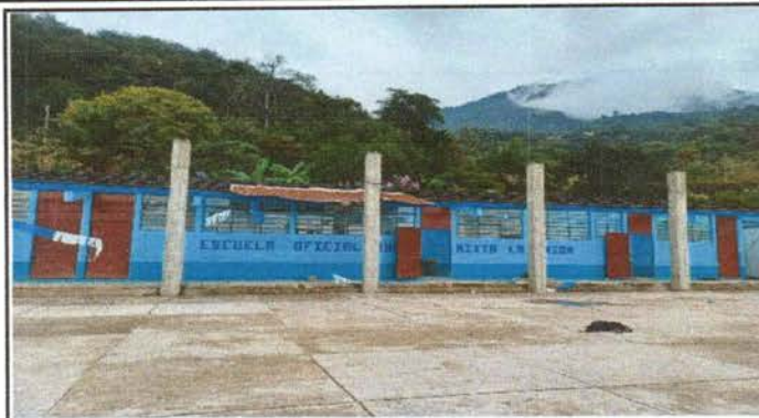
Foto 2: Sustitución de lámina en aulas
