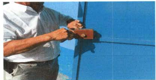
Foto 18: Sustitución de chapas
