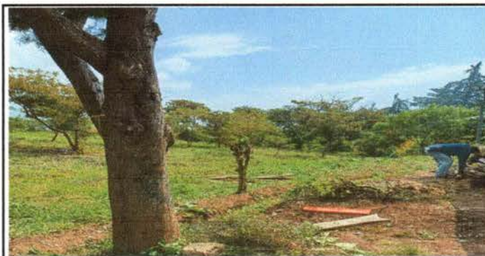
Foto 11: Reparación de cerco de pua
