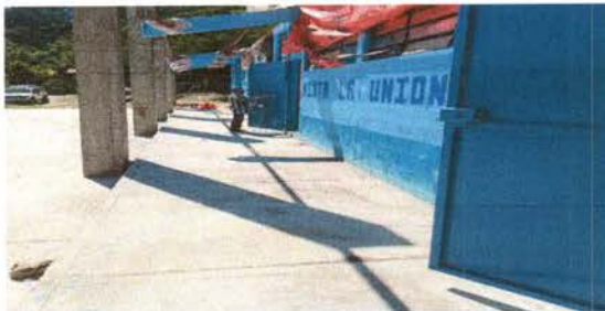
Foto 17: Aplicación de pintura a puertas
