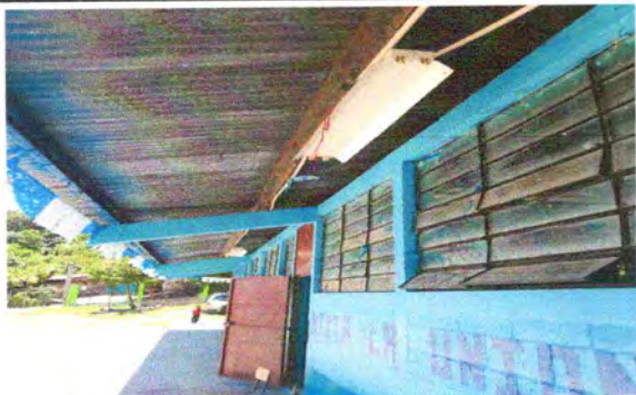
Foto13: Sustrucion de focos ahorradores
