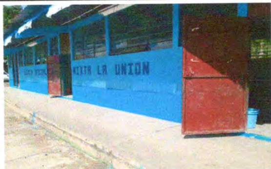
Foto 17: Aplicación de pintura a puertas
