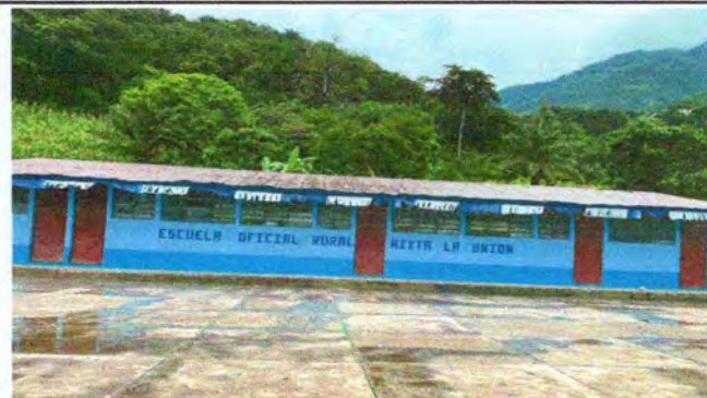
Foto 2: Sustitución de lámina en aulas
