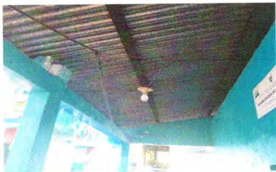
Foto 15: Reparación de cableado eléctrico
