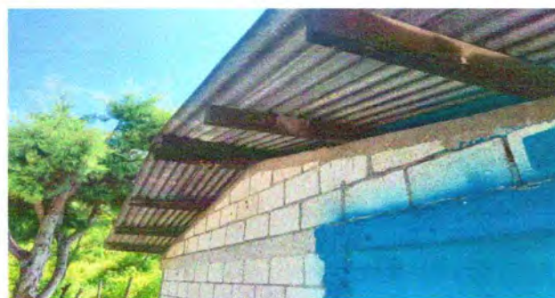
Foto 4: Sustitución de estructura de soporte de madera por metal en techo de cocina escolar
