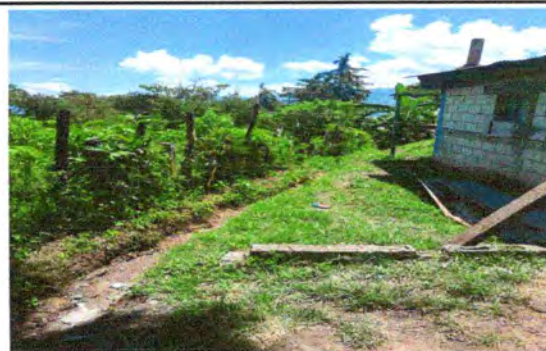
Foto 12: Reparación de cerco de pua
