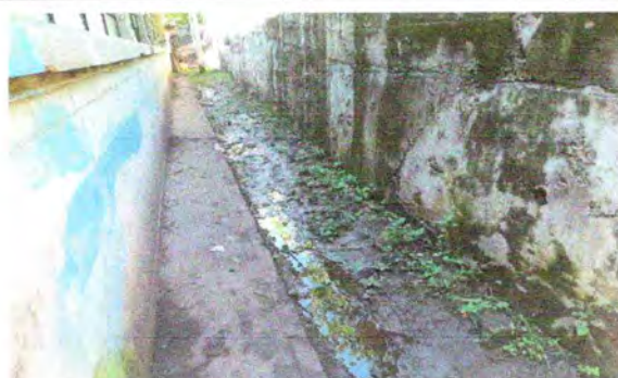
Foto 10: Reparación de cuneta de concreto
