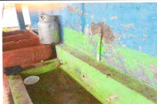
Foto 16: Sustrucion de llaves de chorro
