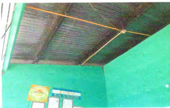
Foto 14: Sustrucion de plafoneras
