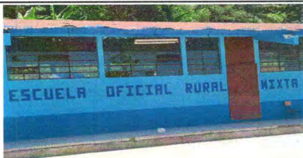
Foto1: Sustitución de lámina en aulas
