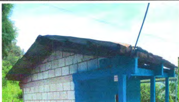
Foto 3: Sustitución de lámina en cocina escolar
