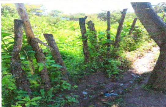
Foto 11: Reparación de cerco de pua
