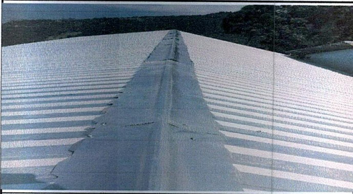
Foto 1: Sustrucción de lamina de techo finalizada.
