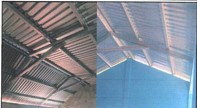
Foto 2: Instalación de costaneras finalizada.
