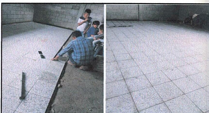
Foto 4: Sustitución de piso en proceso.
