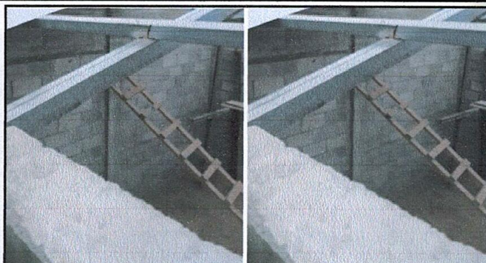
Foto 2: Instalación de costaneras en proceso
