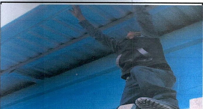
Foto 3: Sustitución de canales en proceso.
