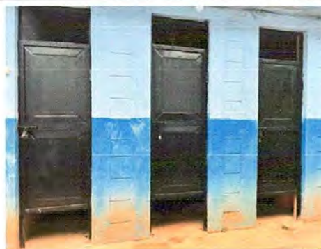
FOTO 10: PINTURA ANTICOROSIVO EN PUERTAS
