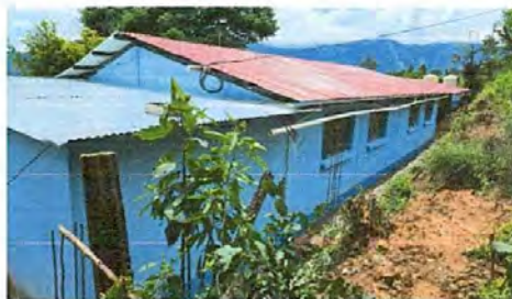
FOTO 2: SUSTITUCIÓN DE CANAL DE PVC
