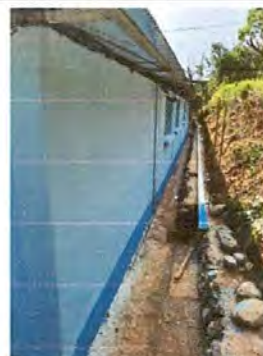
FOTO 4: REPARACIÓN DE CUNETETA
