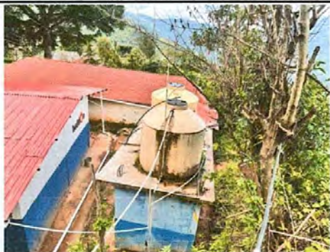
FOTO 11: SUSTITUCIÓN DE TINACO
