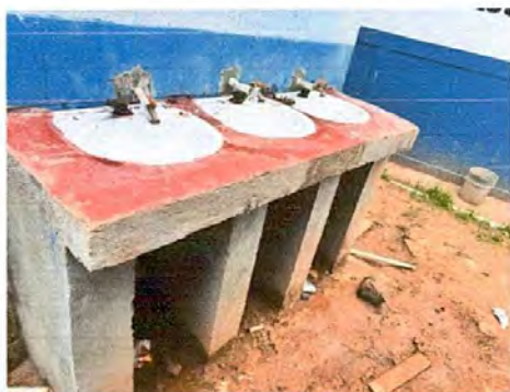
FOTO 9: REPARACIÓN DE LAVAMANOS
