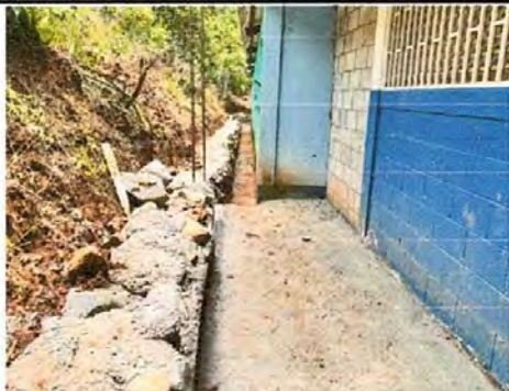
FOTO 5: CONTINUACIÓN DE MURO DE CONTENCIÓN
