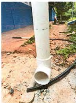
FOTO 3: SUSTITUCIÓN DE LÍNEA PLUVIAL
