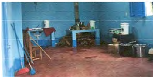
FOTO 6: SUSTITUCIÓN DE PLANCHA
