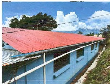
FOTO 8: PINTURA ANTICOROSIVO EN TECHO
