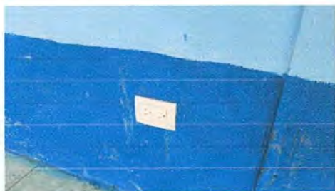
FOTO 7: REPARACIÓN DE TOMA CORRIENTE
