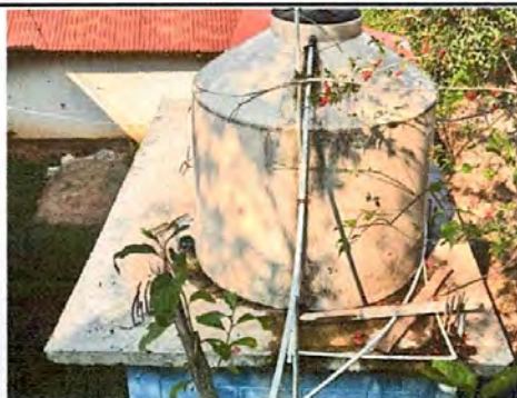
FOTO 11: SUSTITUCIÓN DE TINACO
