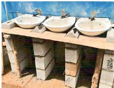
FOTO 9: REPARACIÓN DE LAVAMANOS
