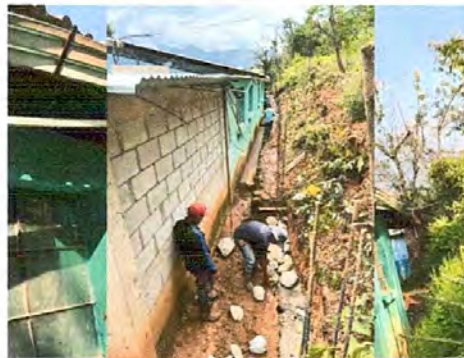
FOTO 2: SUSTITUCIÓN DE CANAL DE PVC
