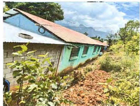
FOTO 8: PINTURA ANTICORROSIVO EN TECHO
