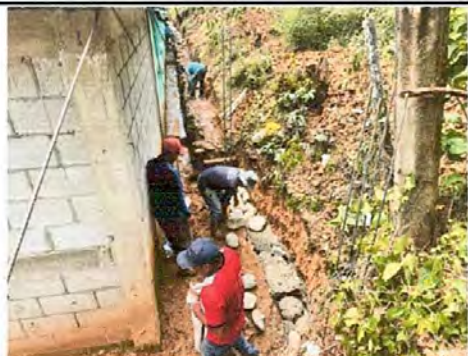
FOTO 5: CONTINUACIÓN DE MURO DE CONTENCIÓN
