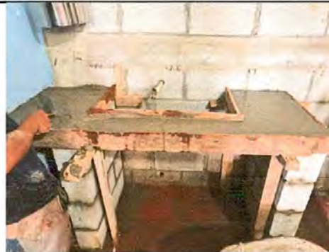
FOTO 6: SUSTITUCIÓN DE PLANCHA
