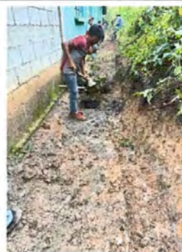
FOTO 4: REPARACIÓN DE CUNETA
