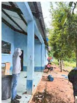
FOTO 3: SUSTITUCIÓN DE LÍNEA PLUVIAL
