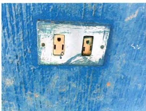
FOTO 7: REPARACIÓN DE TOMA CORRIENTE
