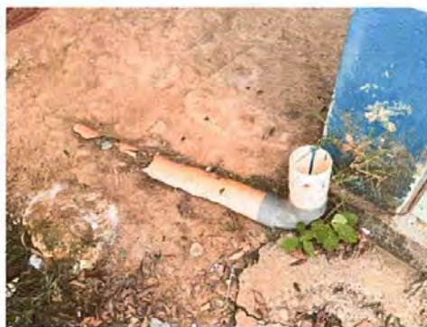
FOTO 3: SUSTITUCIÓN DE LÍNEA PLUVIAL
