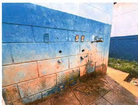
FOTO 9: REPARACIÓN DE LAVAMANOS
