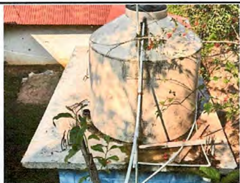
FOTO 11: SUSTITUCIÓN DE TINACO
