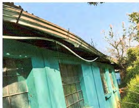
FOTO 2: SUSTITUCIÓN DE CANAL DE PVC
