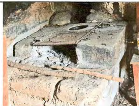
FOTO 6: SUSTITUCIÓN DE PLANCHA
