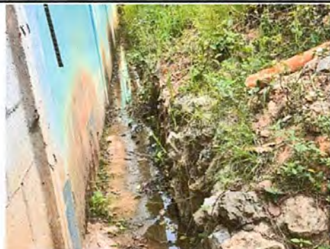
FOTO 5: CONTINUACIÓN DE MURO DE CONTENCIÓN
