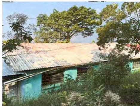
FOTO 8: PINTURA ANTICOROSIVO EN TECHO
