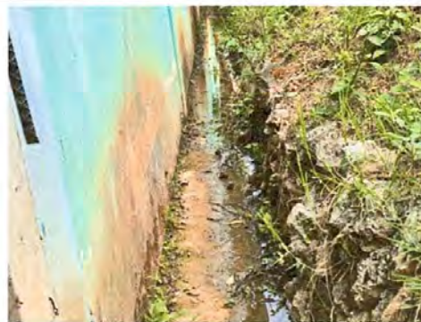
FOTO 4: REPARACIÓN DE CUNETETA
