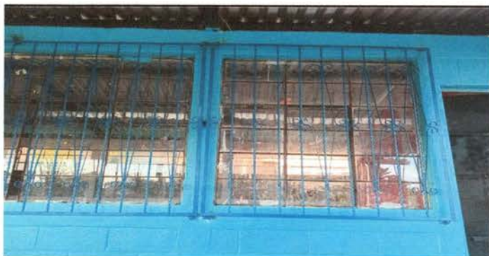
Foto 3: Ventana y balcones finalizados
