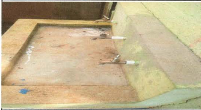
Foto 7: Sustitución de chorros de lavamano finalizado
