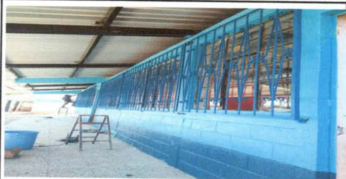
Foto 3: Ventana y balcones en proceso
