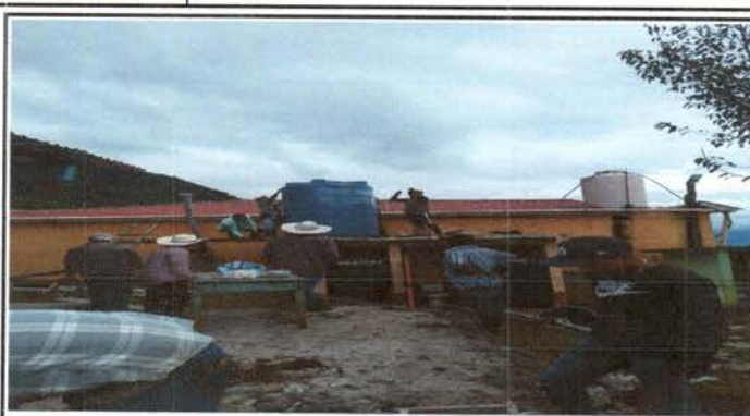
Foto 8: colocacion de tinaco en proceso
