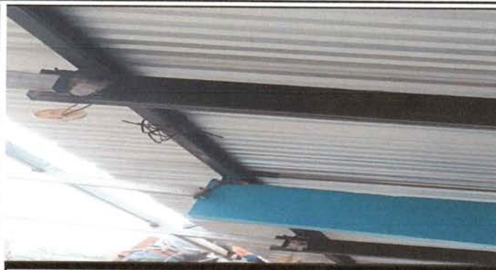
Foto7: Electricidad en proceso
