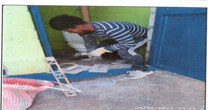
Foto 6 : Sanitarios en proceso
