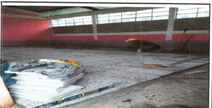
Foto 4: Piso en proceso
