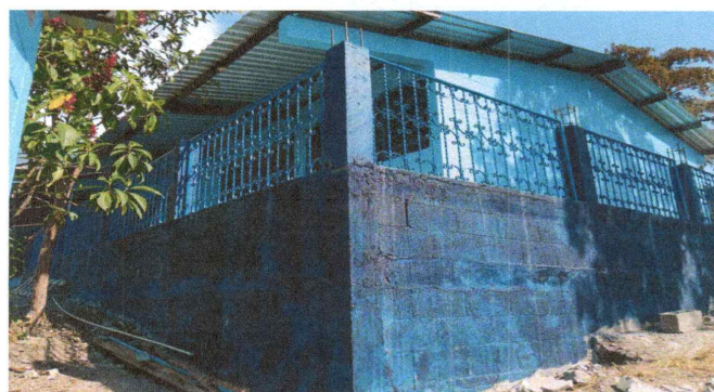
Foto 4: Muro y Barandas
