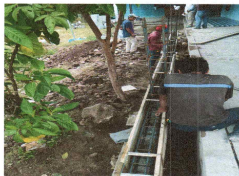
Foto 4: Muro y Barandas
