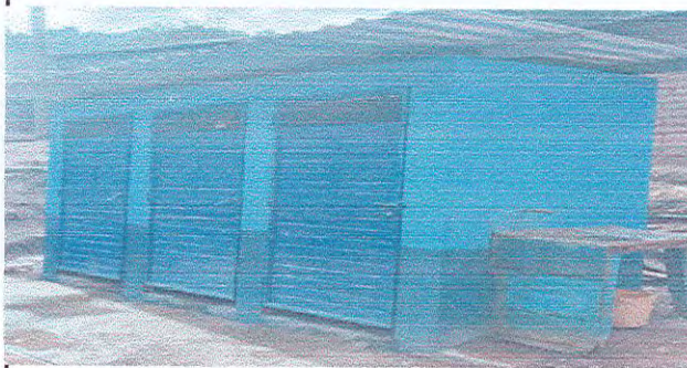
Foto 4: Pintura en todas las las puertas externos e internos
