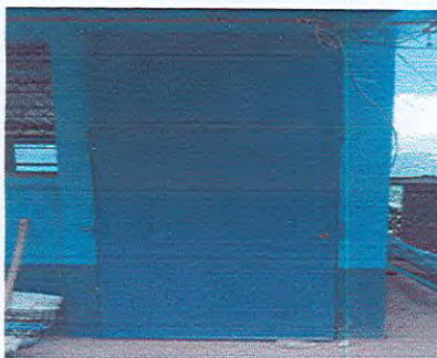
Foto 3: Mantenimiento de puerta
