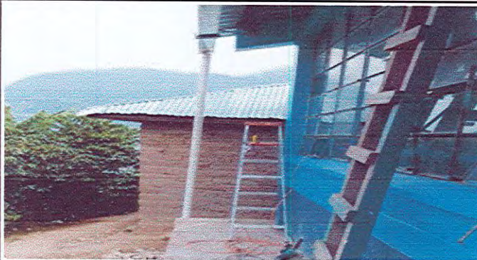
Foto1: Canales y bajadas de agua nuevos
