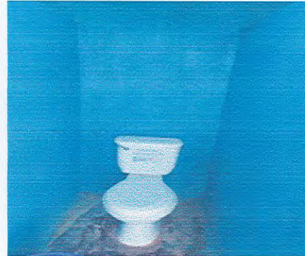
Foto 2: Accesorios para sanitarios reparados
