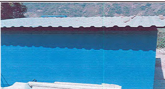
Foto 5: Repeo en paredes de sanitarios
