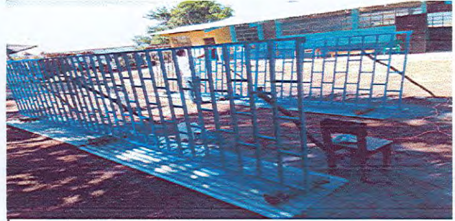
Foto 2: Sustitucion y mantenimiento de los ventanales
