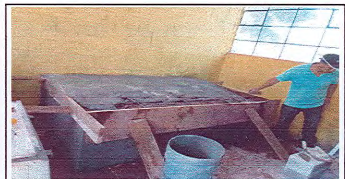
Foto 6: Colocacion de base para las planchas
