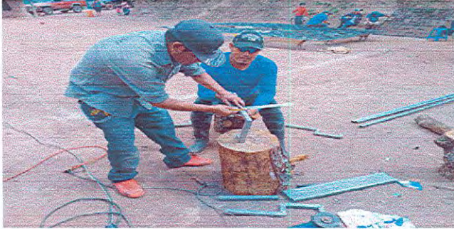
Foto1: Sustitucion de canales de metal
