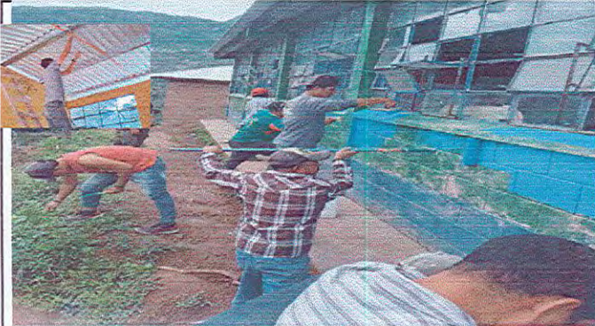
Foto1: Pintura de paredes
