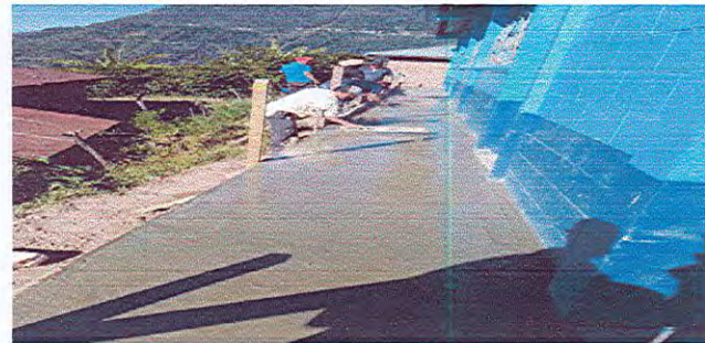
Foto 5: Sustitucion de piso de cemento líquido
