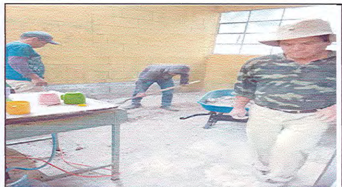
Foto 4: Construcion del fogon
