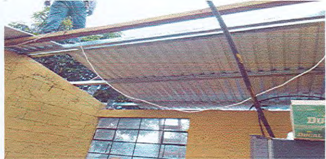
Foto 6: Sustitucion de lamina galvanizada
