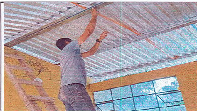
Foto 3: Colocacion de ducto y cable electrico nuevo
