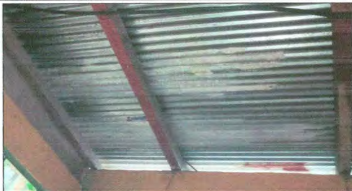
Foto 2: Estructura de soporte de madera.
