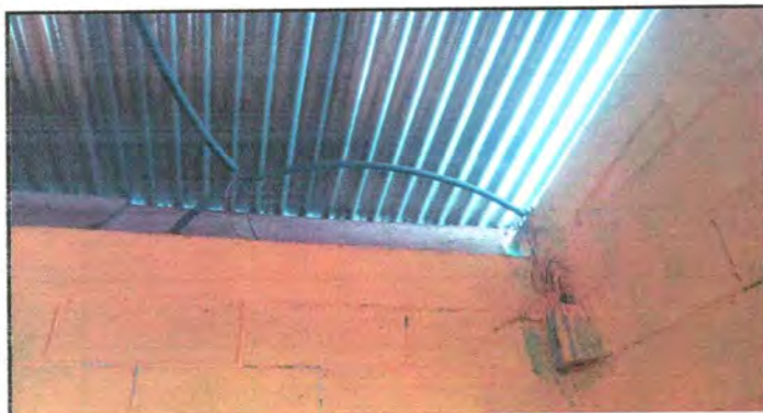
Foto 3: sustitución de cableado eléctrico.
