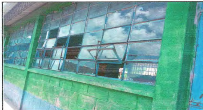
Foto 4: Sustitución de estructura de metal mas vidrio.
