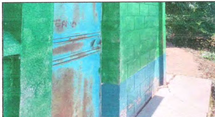
Foto 3: Mantenimiento a puerta de metal.
