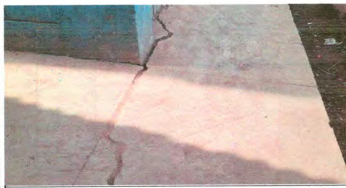
Foto 5: Sustitucion de piso de torta de cemento
