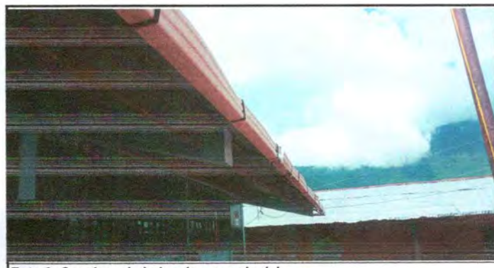
Foto 6: Canales y bajadas de agua pluvial
