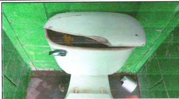
Foto 2: Sustitución de accesorios en sanitarios
