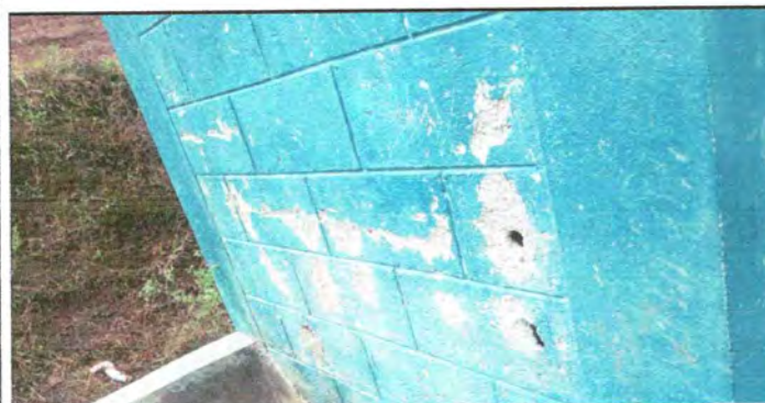
Foto 5: Repello en paredes de servicio sanitario
