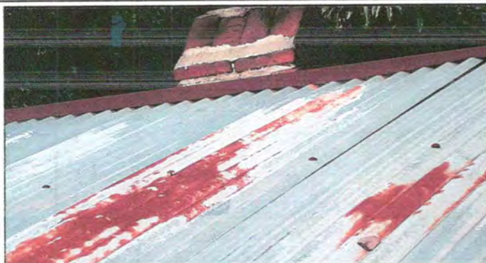
Foto1: Cubierta de lámina
