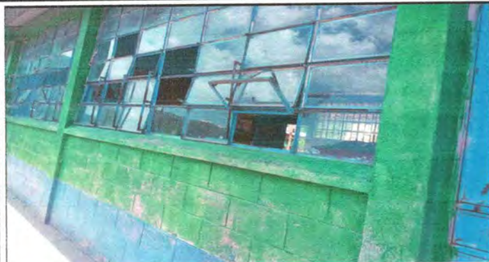
Foto 1: Pintura en paredes.
